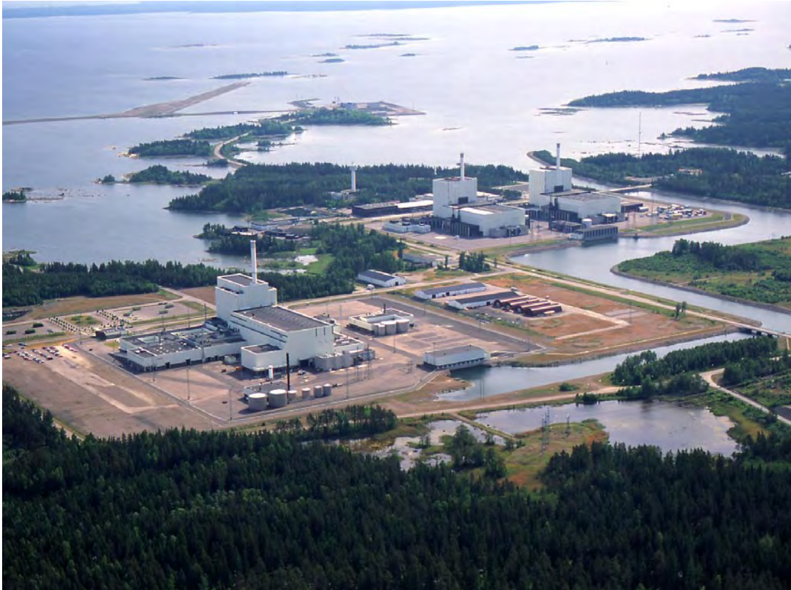
Figur 2-9. Industriområdet i Forsmark, med de tre reaktorbyggnaderna och i bakgrunden SFR-anläggningen.
