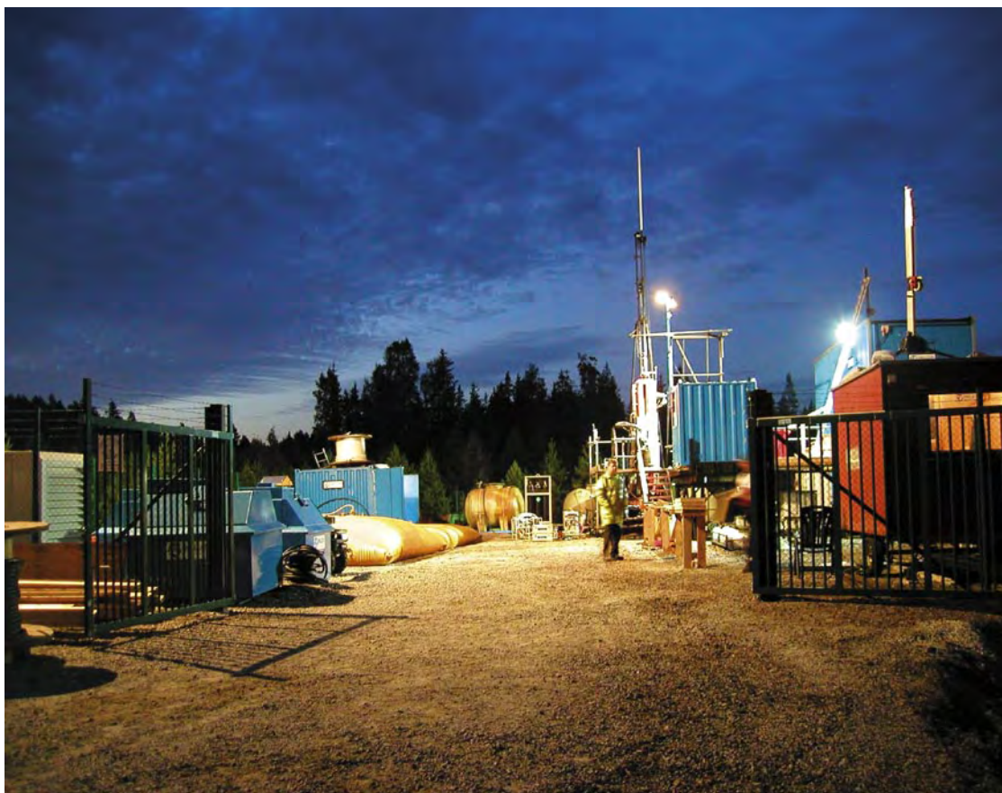
Figur 3-28. Borrplats 1 under borringen av platsundersökningens första djupa kärnborrhål.
