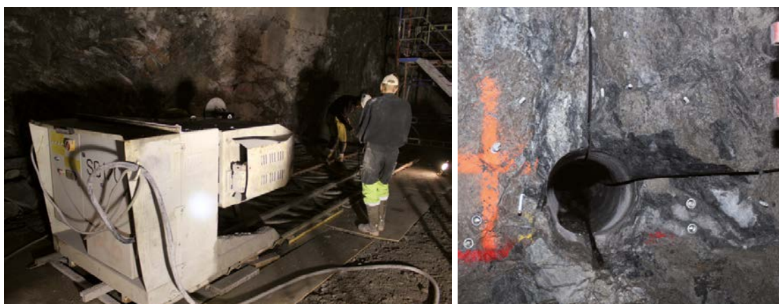
Figur 3-5. Foto av utrustningen för drivning av diamantvajern och till höger visas en närbild av det nedre hörnhålet efter det att sågningen blivit utförd.
