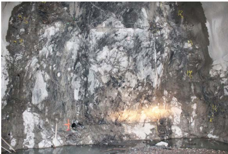
Figur B1-3. Foto av fronten färdigborrad inför laddning av salva 1.
