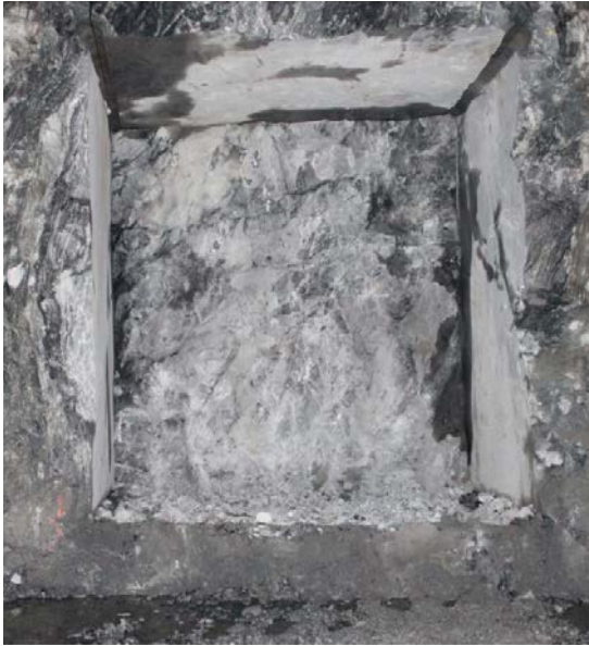
Figur 4-4. Foto av stuffen efter sprängning och utlastning av salva 1.
