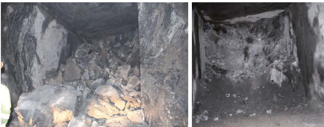
Figur 4-5. Foto till vänster visar stuffen efter sprängning av salva 2 och fotot till höger visar stuffen efter utlastad salva.
