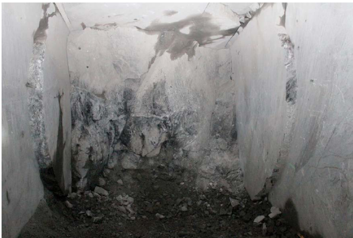
Figur 4-7. Foto av stuffen efter sprängning och utlastning av salva 4.
