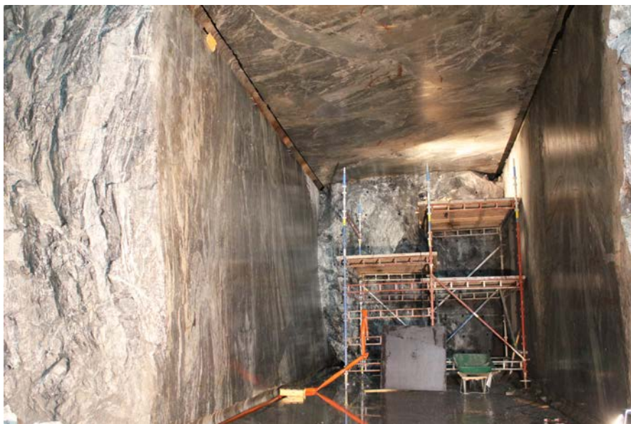
Figur 4-2. Etapp 2 – För att kunna utföra borrningen av hålen på den övre nivån krävdes det byggande av fasta ställningar och plattformar. I verklig produktion av deponeringstunnlar kommer de fasta ställningar att ersättas med mobila lyftplattformar för att uppnå ett rationellt arbete.
