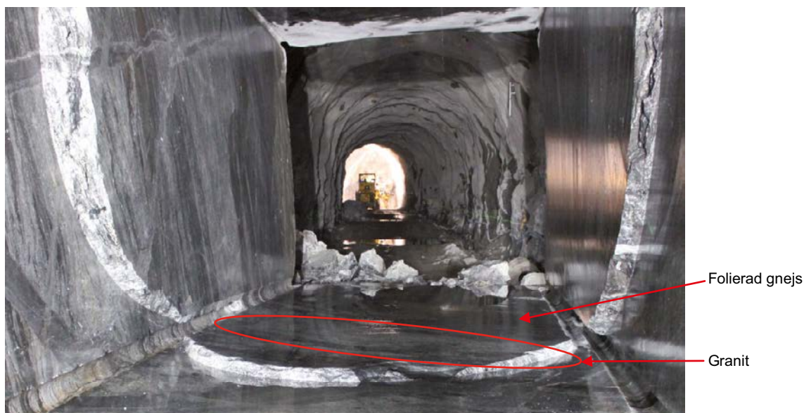
Figur 5-10. Detaljbild av tunnelgolvet i etapp 2 där markradarmätningar gjordes. Bergarten varierar från granit till folierad gnejs.
