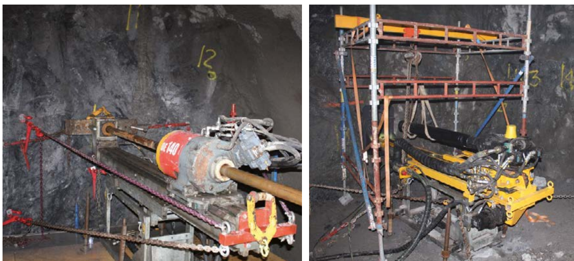
Figur 4-1. Etapp 1 – Den vänstra bilden visar borrning av kärnborrhålet \varnothing 76 mm. Genom byte av bom på borrarregaget (högra bilden) genomfördes upprymning av kärnborrhålet i två steg, från \varnothing 76 mm till \varnothing 165 mm och sedan från \varnothing 165 mm till \varnothing 255 mm. Ingen ny uppställning krävs för dessa upprymningssteg.
