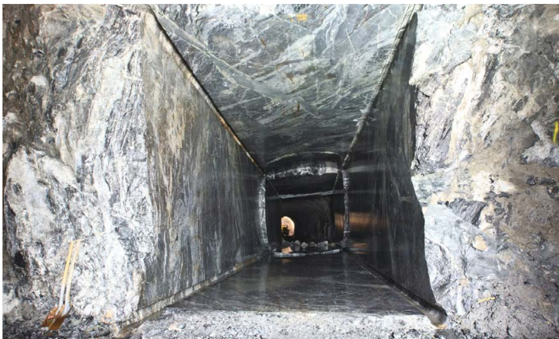
Figur 5-1. Översiktsfoto av den färdigsprängda tunneln, Etapp 1 närmast kameran.
