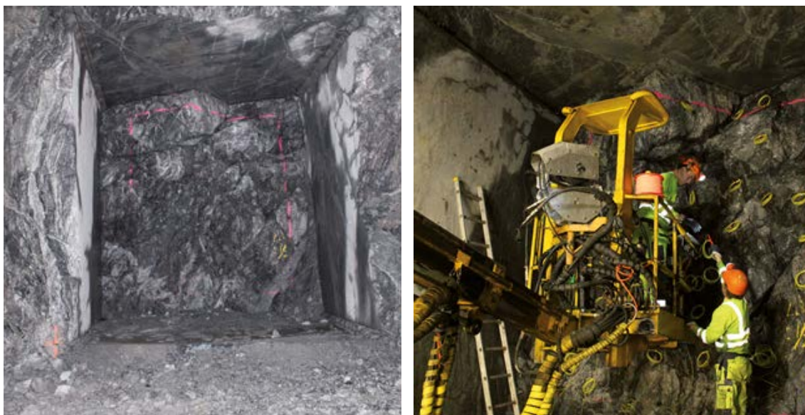
Figur B1-4. Foto av fronten inför salva 2 och till höger visas laddningen av salva 2.
