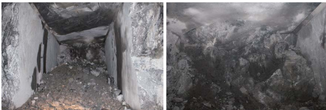
Figur 4-6. Foto av stuffen efter sprängning av salva 3. Den högra figuren visar även den kvarstående halvmånformade bergklacken i taket.
