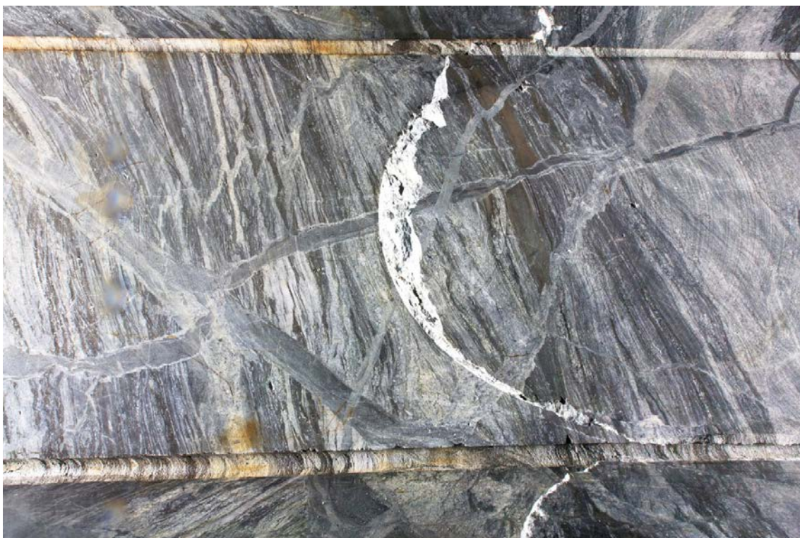
Figur 5-3. Detalj av den färdigsprängda tunneln, vänster vägg vid övergången mellan de två etapperna.
