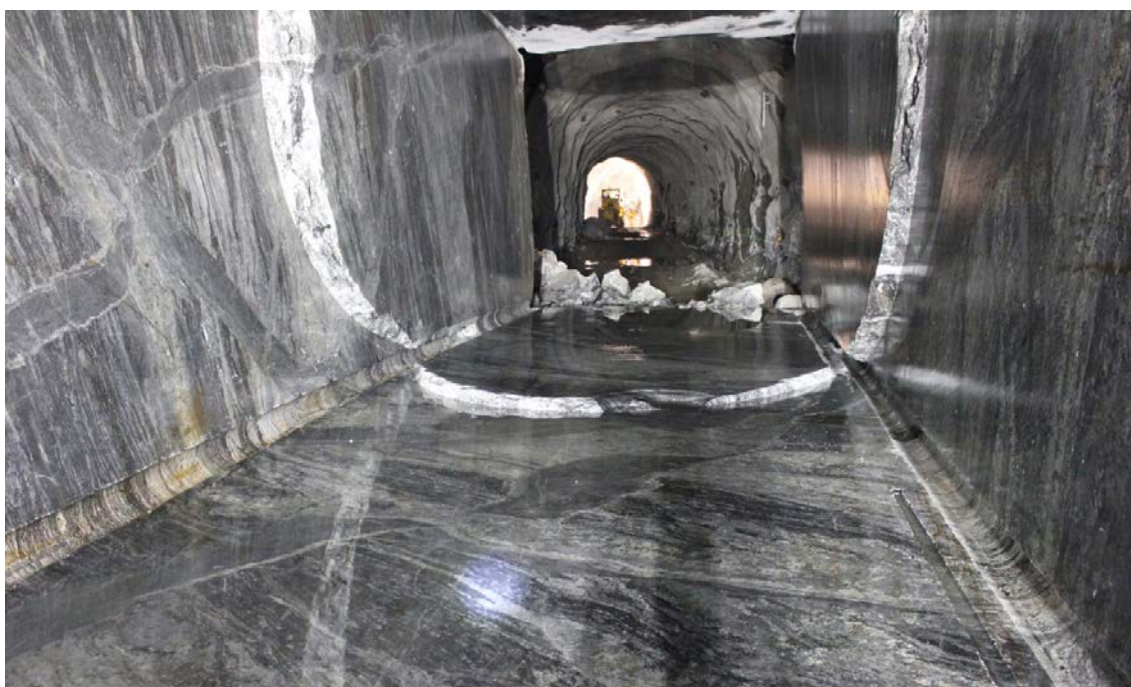
Figur 5-2. Detalj av den färdigsprängda tunneln. Det ljusa fältet är trappningen mellan Etapp 1 och 2.
