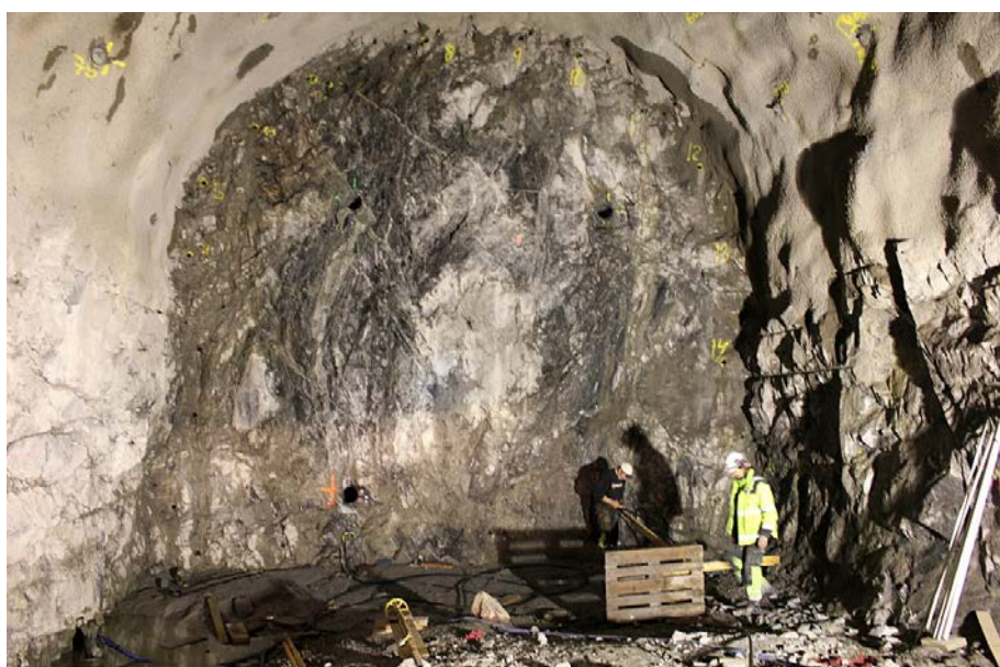
Figur 3-1. Foto av fronten av spårtunneln med de fyra hålen i hörnen av den rektangulära deponeringstunneln borrade.
