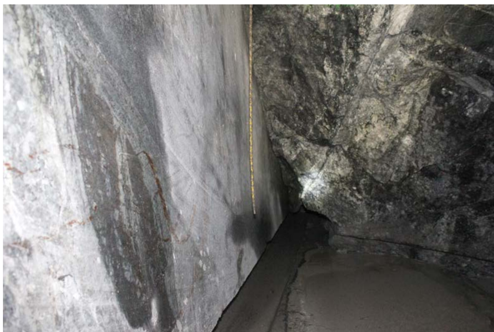
Figur 4-3. Under sågningen i Etapp 2 inträffade ett brott på diamantvajern (vertikal gul linje mitt i bild vid bergytan).
