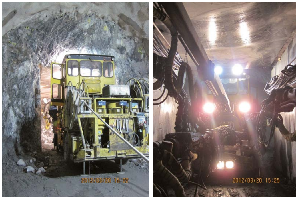
Figur B1-1. Borr aggregat för borrning av hålen för sprängningen – Atlas Copco Rocket Boomer 353.
