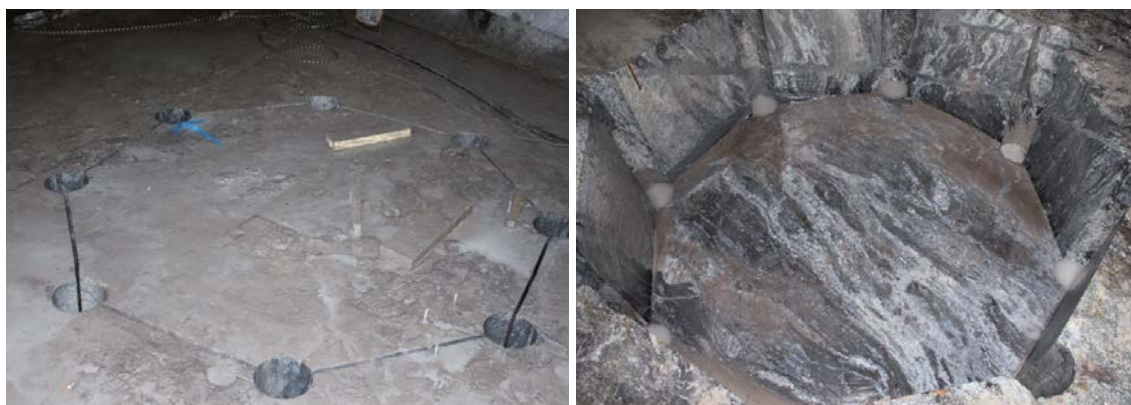
Figur 5-11. Fotot till vänster visar borrhålen och sågade sidor (jämför figur 3-9). Fotot till höger visar utseendet när bergpluggen är borttagen.
