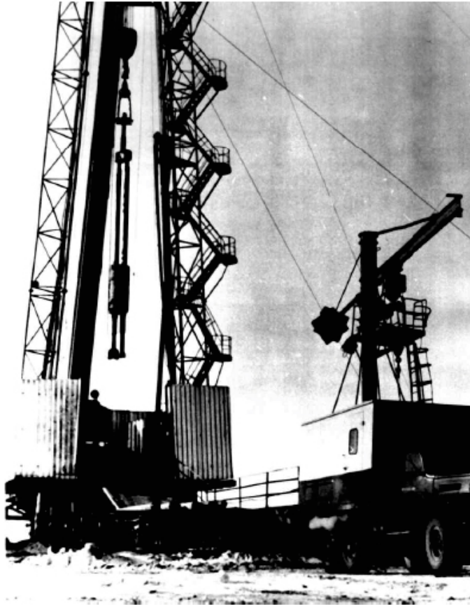
Figur 5-23. Borrrigg för borrning av borrhål för underjordiska kärnvapensprängningar. (Adushkin och Leith 2001).
