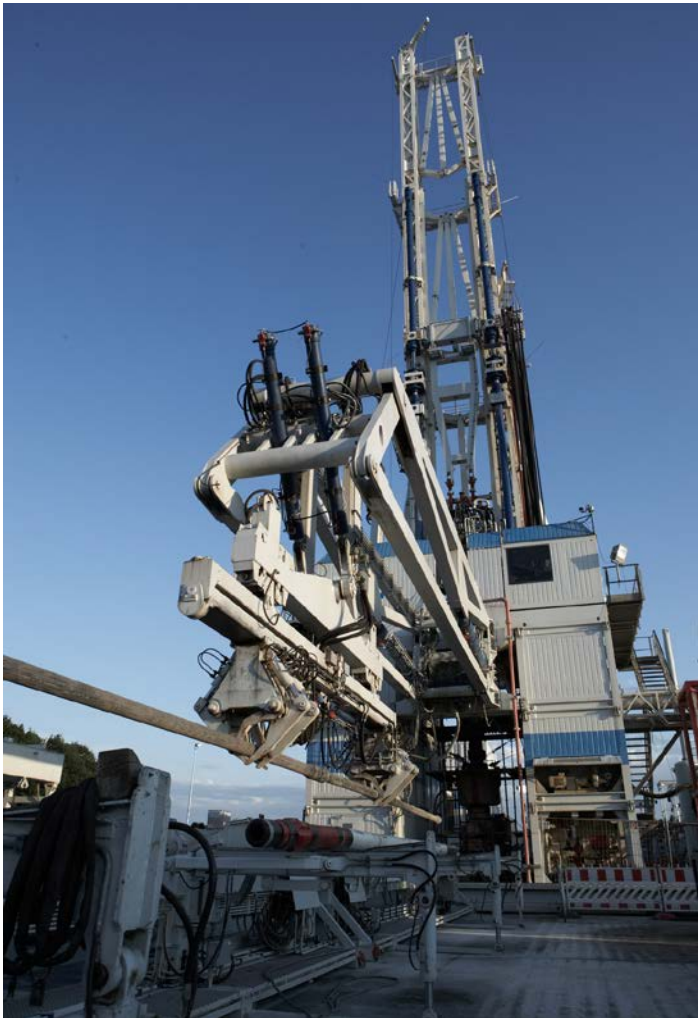
Figur 5-27. Kranen som lyfter de horisontellt liggande rören och skarvar dem till vertikala borrhsträngen.
