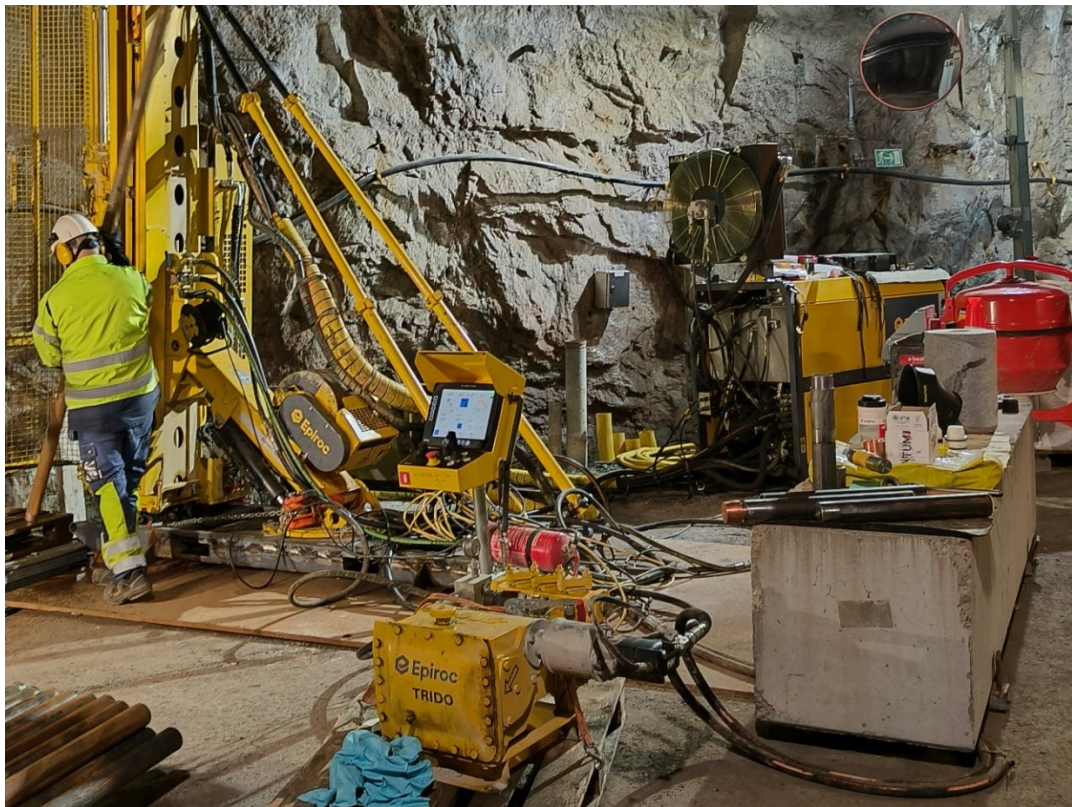
Figur 4-3. Bormaskin på plats. Betongblocket stabiliserar körplåten i vilket bormaskinen är fastsvetsad.
