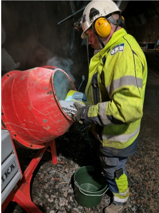
Figur 5-3. Betongen blandas enligt recept med 2,7 L vatten per 20 kg säck. Efter 10 minuter i blandaren är betongen färdig och fylls på i borrör i den volym som har beslutats att fyllas upp i borrhålet.
