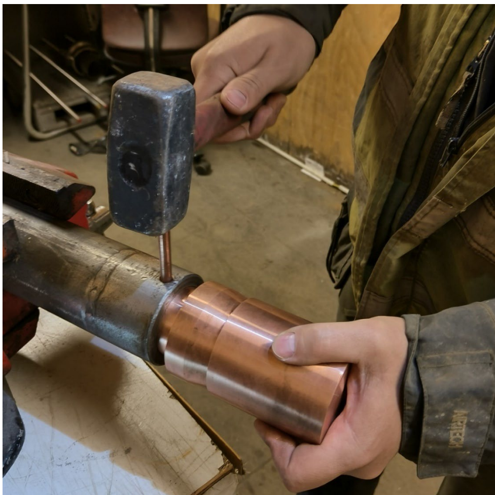
Figur 5-7. Kopparexpandern ansluts till monteringsröret med en 8 mm brytpinne, också den av koppar.
