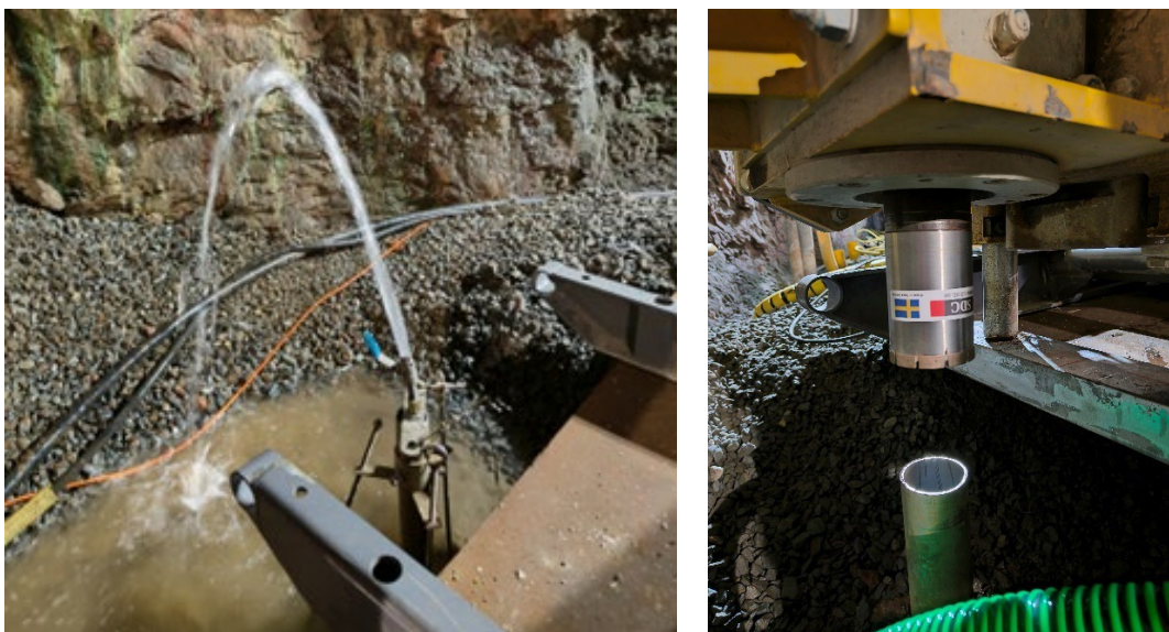
Figur 4-5. T.v.: Med grävmaskin rensades asfalt och grus bort runt borrhålet ner till sulan och när den manschett som fanns i hålet öppnades var flödet ca 9 L/min. T.h.: Det rostfria foderröret överborrades med ett specialtillverkat rör och borkrona med dimensionen \text{Ø } 64/74 \text{ mm} .
