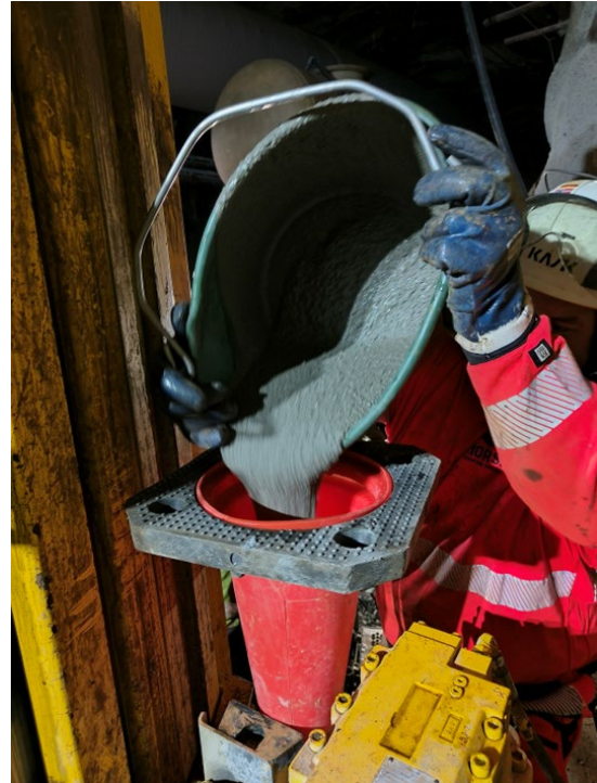
Figur 5-3. Betongen blandas enligt recept med 2,7 L vatten per 20 kg säck. Efter 10 minuter i blandaren är betongen färdig och fylls på i borrör i den volym som har beslutats att fyllas upp i borrhålet.
