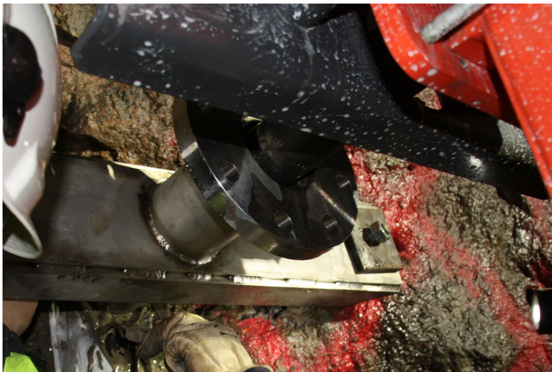
Figur 4-5 Det cementfyllda foderröret förs nu in i borrhålet och tvärbalken förankras med gängstängerna. Borrmaskinen trycker på pluggen så att cementen pressas ut i spalten mellan foderrör och borrhålsvägg. När cementen når borrhålsmyningen tätas spalten med drevning.
