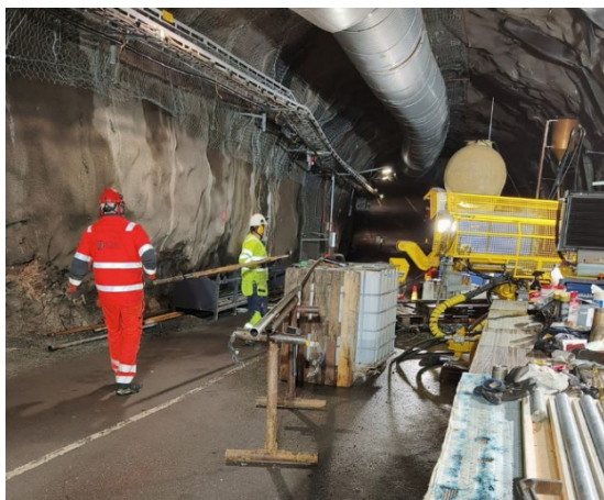
Figur 4-8 Borrhärnehantering. Genom att ha två innertuber tillgängliga kortas borrhärskeln. Så fort innertuben med borrhären är uppe pumpas den andra innertuben ner i borrhären. I den digitalt styrda bormaskinen behöver borrhären ställa in borrhärparametrarna och övervaka borrhärprocessen på datapanelen.
