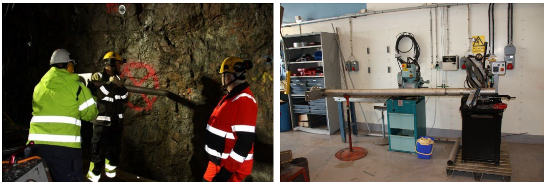
Figur 4-3. T.v.: När borrhålet hade rymts upp fördes foderröret in och mättes upp så att det fanns ett utrymme för plastpluggen att gå in i rymningen, samtidigt som tvärbalken passade mot bergväggen. T.h.: Foderröret kapades i SFR-verkstanen ovan jord till det justerade måttet.
