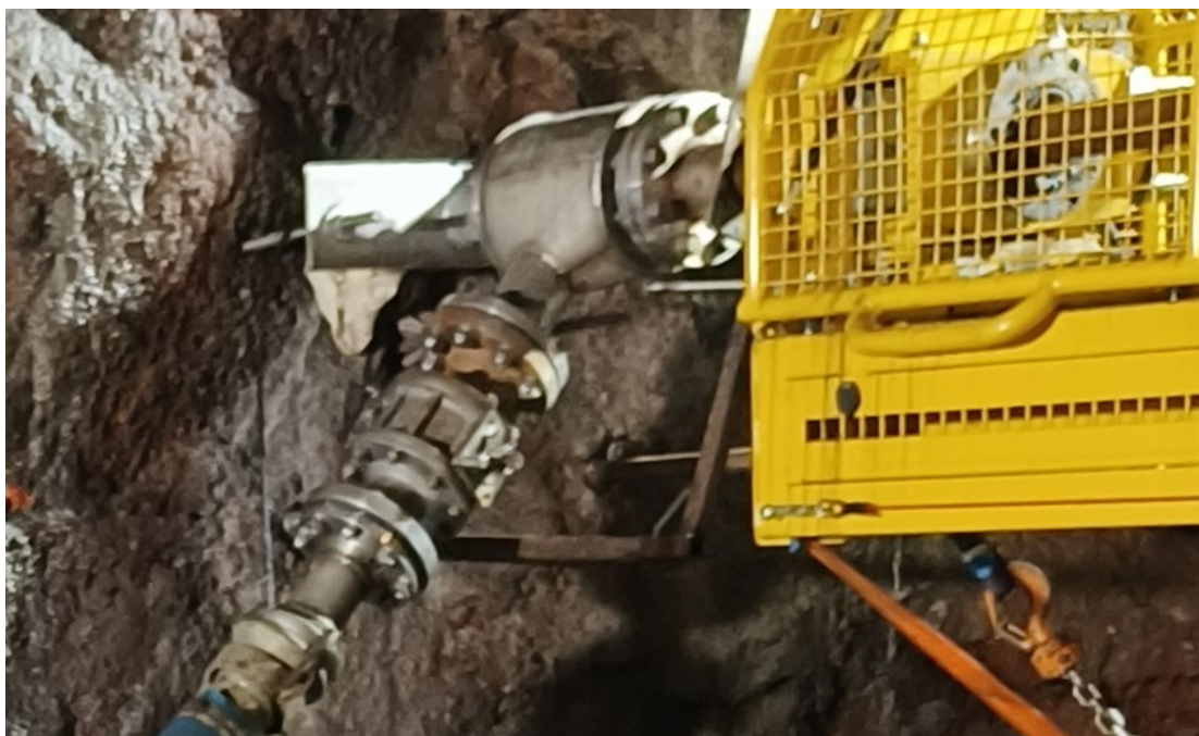
Figur 3-4 När foderröret är ingjuter och väl förankrat i bergväggen skruvas ett ventilt paket med sidoutkast fast på foderrets fläns. Därefter kan nu även bormaskinens balk fästas i bergväggen så att bormaskinen blir väl förankrad under borrhningens genomförande.
