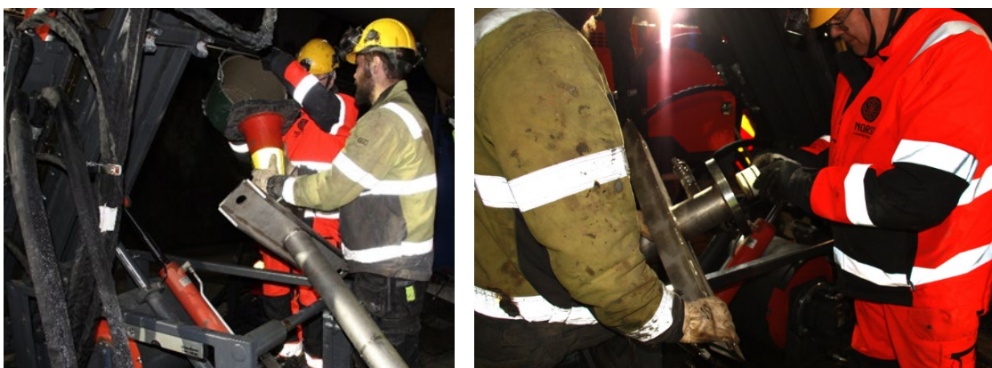
Figur 4-4 Foderröret fylls upp med cement och en plugg tätar foderröret innan det lyfts in i det rymda borrhålet.
