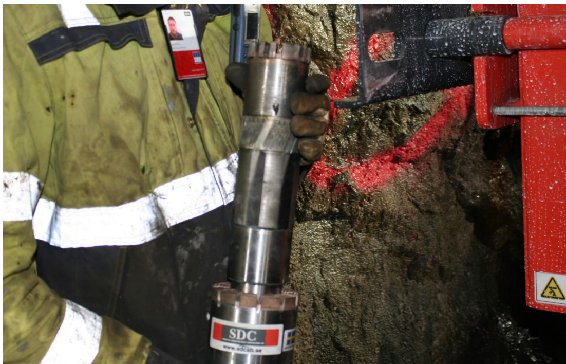
Figur 4-2 Bilden visar rymningsverktyget som användes för att rymma upp N-borrhålet till 107 mm diameter. Piloten med N-borkrkrona och kaliberring passar perfekt i det förborrade N-borrhålet.
