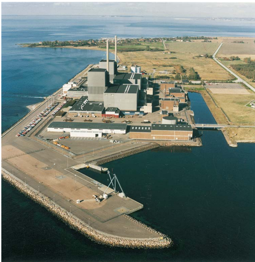
Figur 15-1. Vy över Barsebäcks kärnkraftverk med de två BWR-reaktorerna B1 (närmast i bild) och B2.
