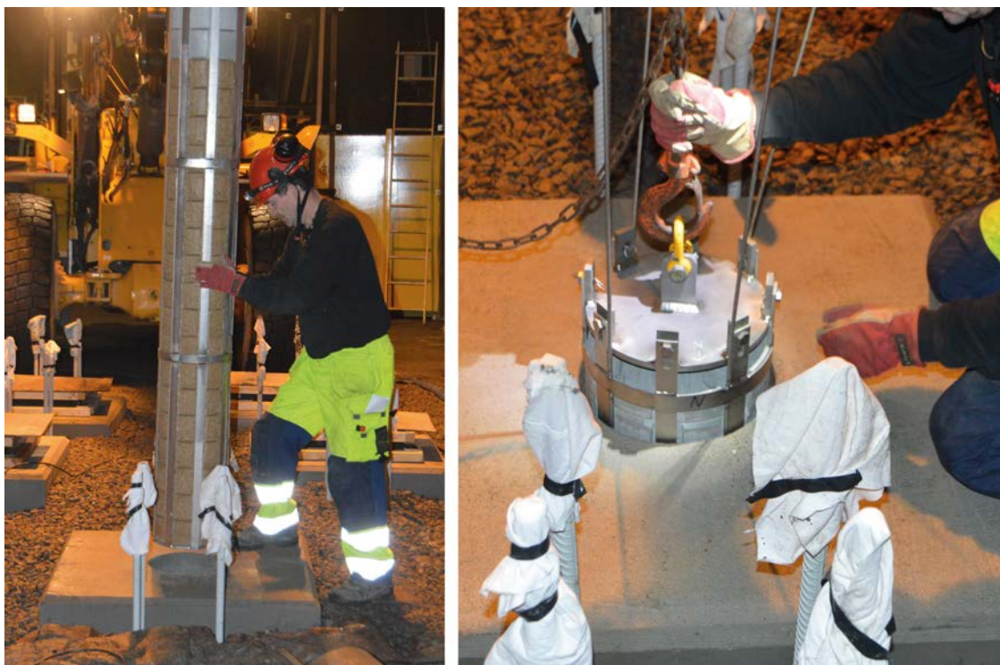
Figur 9-3. Installation av ett paket med 30 bentonitblock. Varje block innehåller även fyra mindre materialprover.
