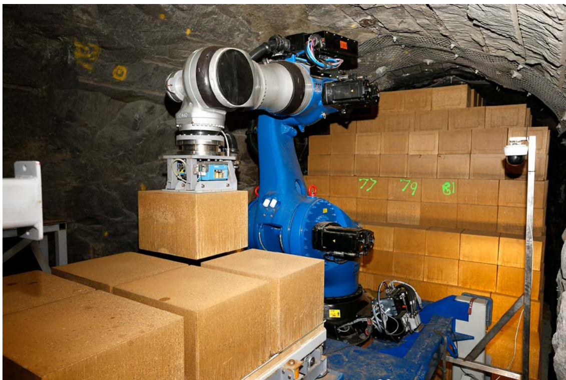
Figur 10-19. Blockinstallation på 450 meters djup vid Äspölaboratoriet.
