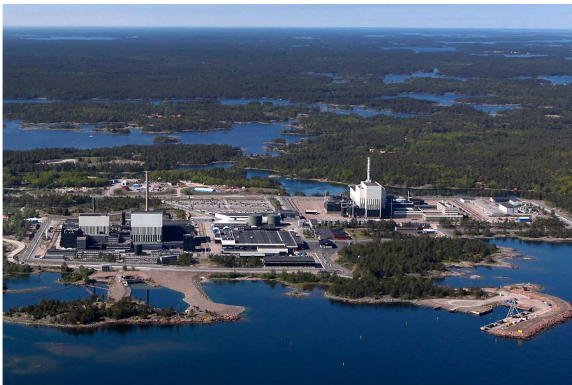
Figur 15-3. Vy över OKG:s kärnkraftverk med de tre BWR-reaktorerna O1, O2 och O3 från vänster till höger i bild.
