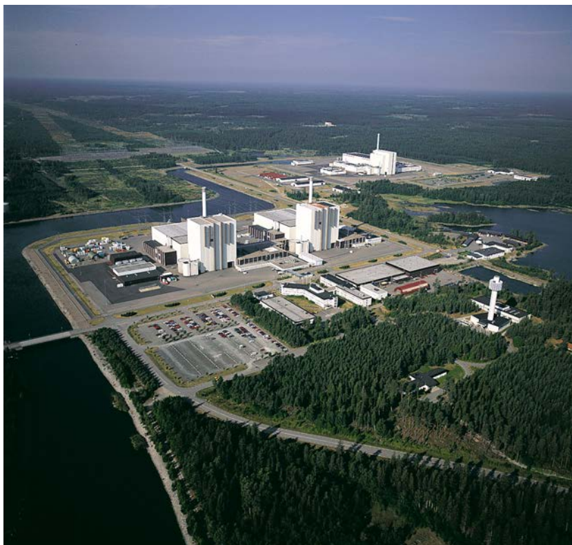
Figur 16-3. Forsmarks kraftstation med de tre BWR-reaktorerna F1, F2 och F3 från vänster till höger i bild.
