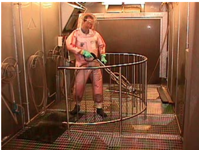
Figur A-19. Arbete inne i glasbläster.
