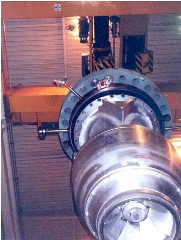
Figur 6-14. Efter pumpdekontaminering med NITROX-E.
