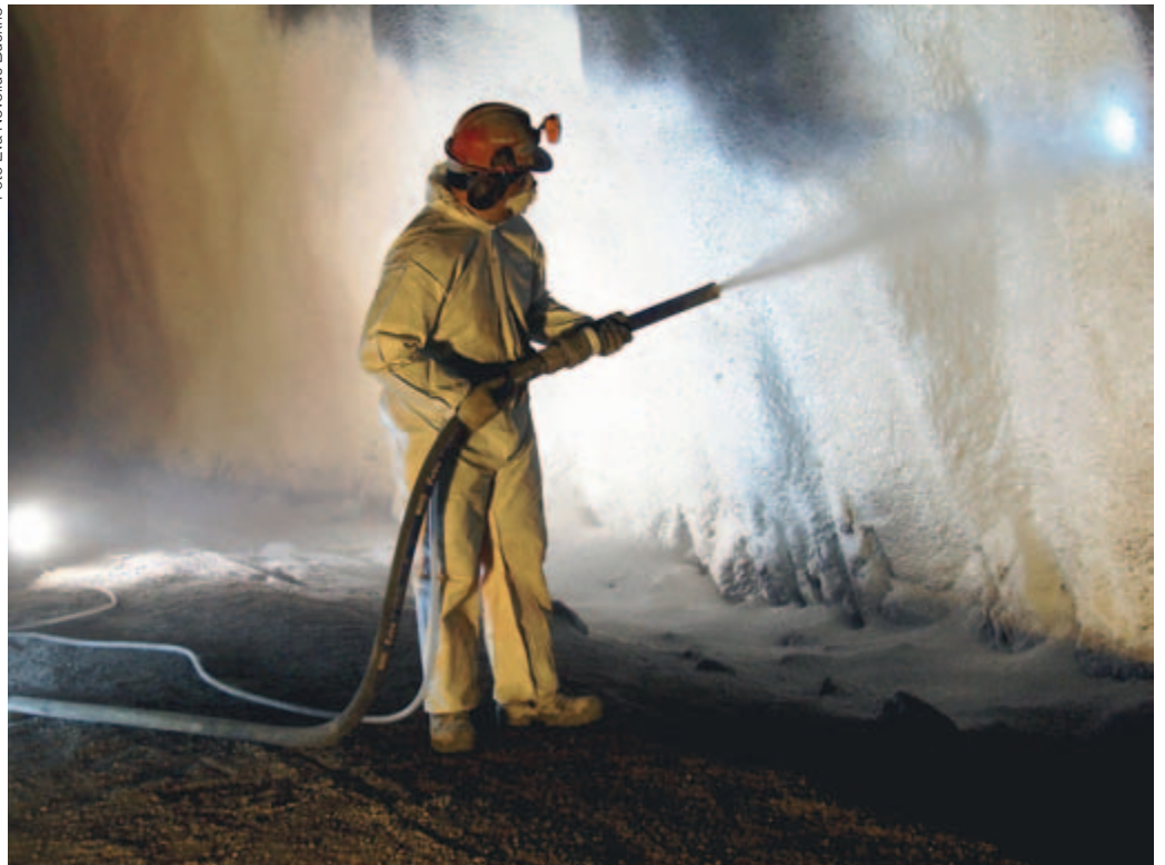
Polymer sprutas på tunnelväggen nere i SFR. Det handlar om en ny metod för att undvika droppande vatten nere i berget som kallas tätmembran.
