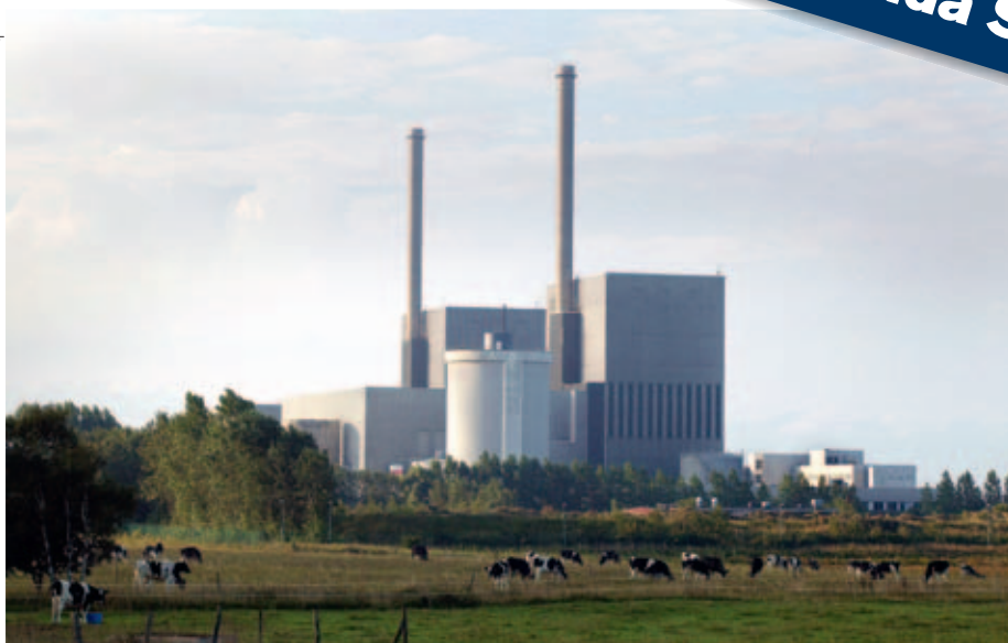
Barsebäcks kärnkraftverk väntar på rivning. Men för att det ska kunna ske måste Slutförvaret för kortlivat radioaktivt avfall i Forsmark byggas ut.
