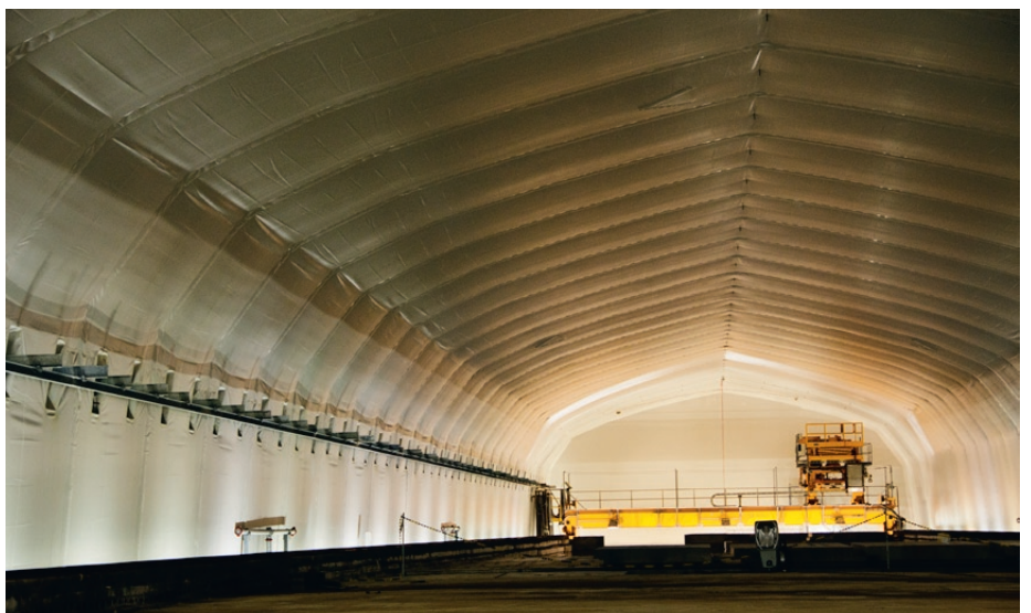
Över 9 000 kvadratmeter tunnelduk har installerats.
