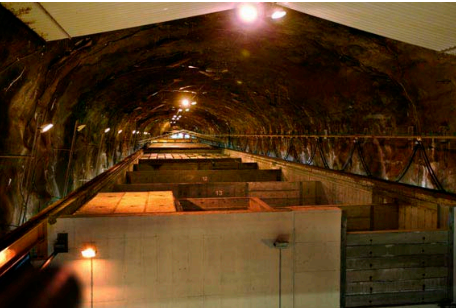
Under jorden. En av bergsalarna i SFR under Öregrundsgrepen.
