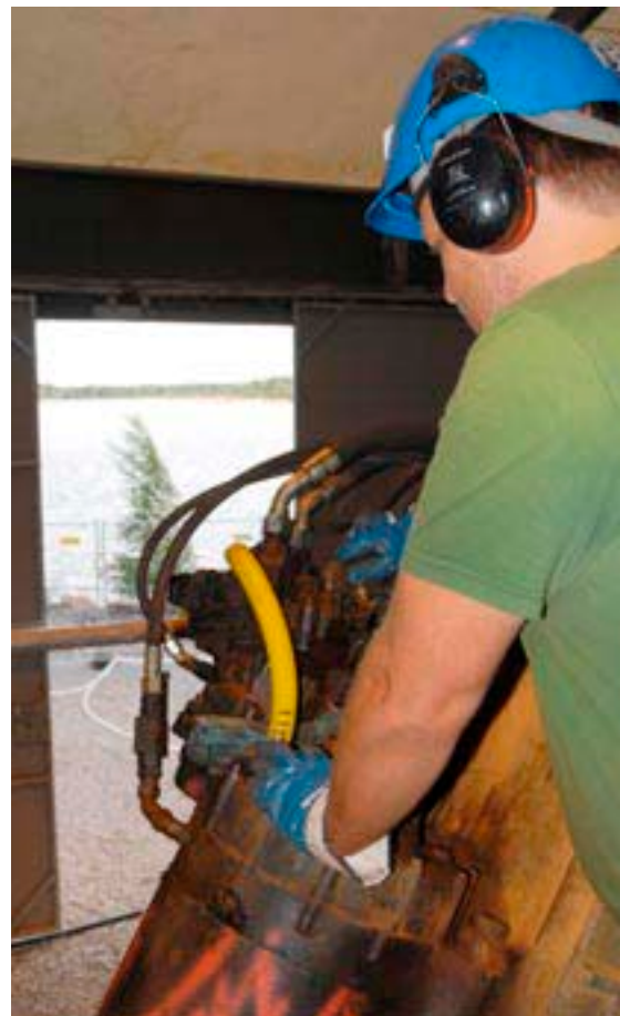
Höstens borrhningar är i gång. Henry Karldorff från Drillcon sköter borrhningen från borrhåls elva i Forsmarks hamn. Utsikten är inte den sämsta.
