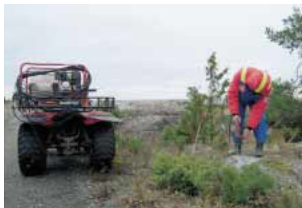
Seismiska sprängningar förbereds. Bo Bergström från Långalma Jord & Gräv AB borrar hål vid vägen till Biotestsjön. Seismiska mätningar visar var möjliga sprickzoner kan finnas.
