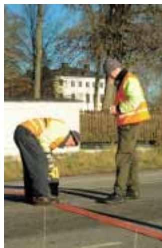
Mätningar i bruket. Seismiska mätningar förbereds vid herrgården i Forsmark.
