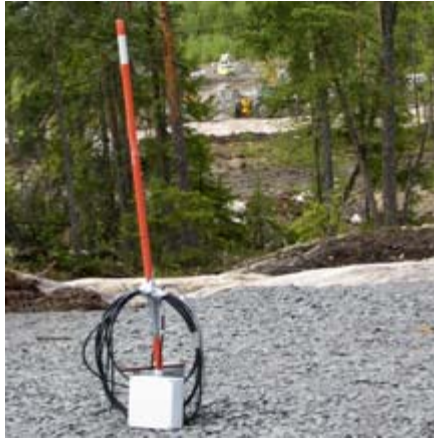
Det sista av de 28 djupa kärnborrhålen. Bakom träden pågår byggandet av förrådsutrymmen.
