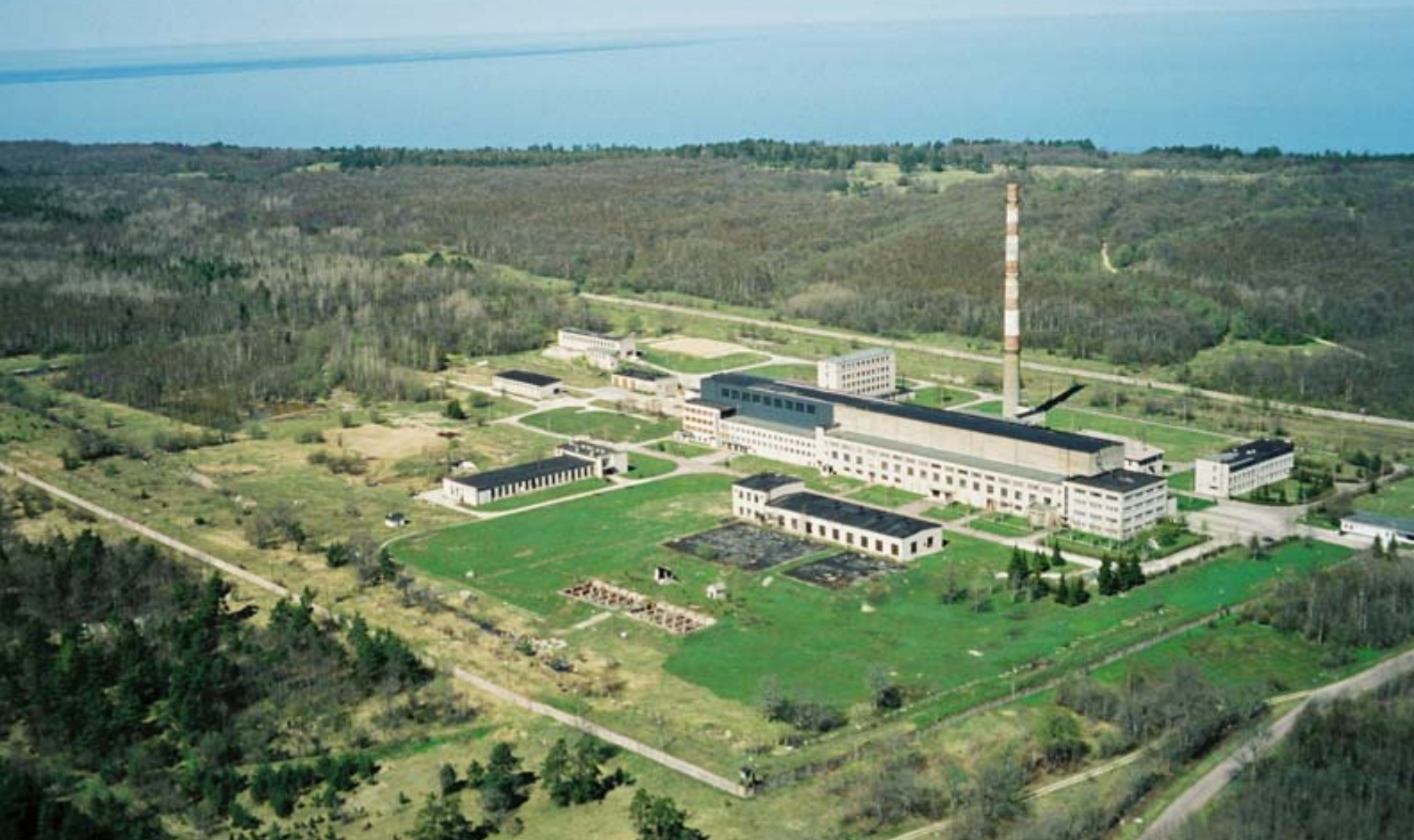
Paldiskibasen vid inloppet till Finska viken. När bilden togs hade flera byggnader hunnit rivras och flera har rivits senare. Foto: AS Alara
