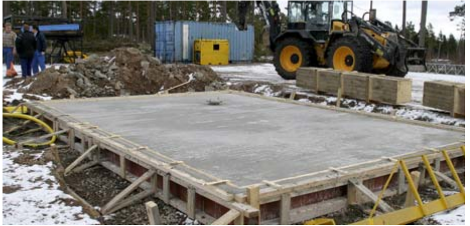
Den första borrhållsplatsen i Laxemar förbereds för kärnborrhål. Betongplattan hindrar att miljöfarliga ämnen, exempelvis hydraulolja från bormaskinen, läcker ut i marken.
