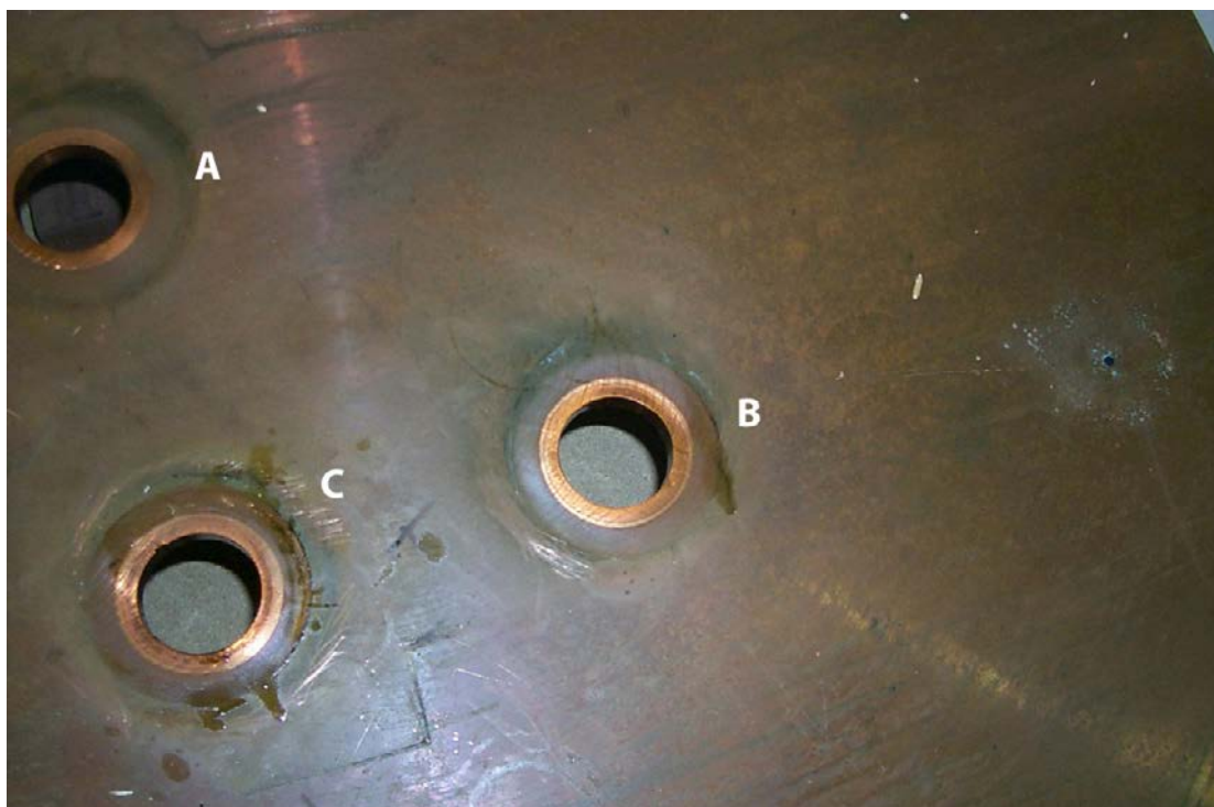
Figur 6-3. Det avlyfta kopparlockets undersida med hålmarkeringar A–C. Litet hål för gasprovtagning långt till höger i bilden.
