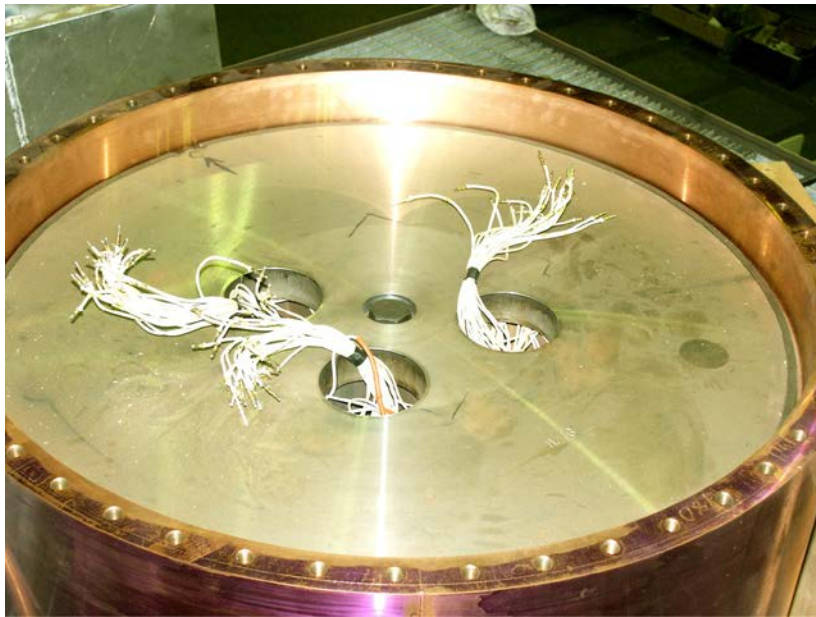
Figur 3-5. Koppar/järnkapsel efter installation av själva värmarelementen samt stållocket men före det att kablarna kopplats till gismapluggarna (se figur 3-8).
