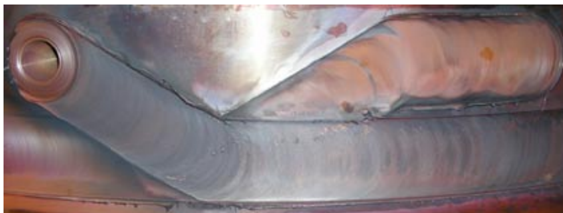
Figur 6-18. Startområdet (höger) och utgångshålet (vänster) ovanför foglinjen.
