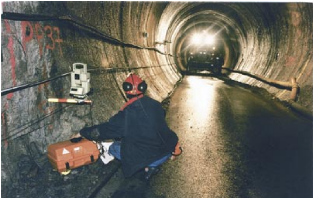
Figur 1-2. Äspölaboratoriet består av en 3 600 meter lång tunnel som går ner till 460 meters djup.
