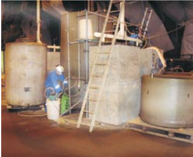
Figur 10-4. Fotot till vänster visar försöksuppställningen som användes vid uppslammningsförsöket – uppslamning sker i tanken i mitten. Till höger visas hur bentonitleran slammas upp med hjälp av en saltlösning.
