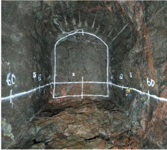
The TASS-tunnel in Äspö HRL.
