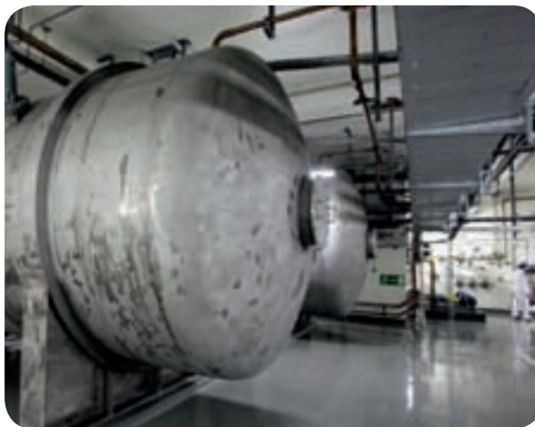
Figur 8-4. Uppsamlingsstankar för processvatten på Clab.
