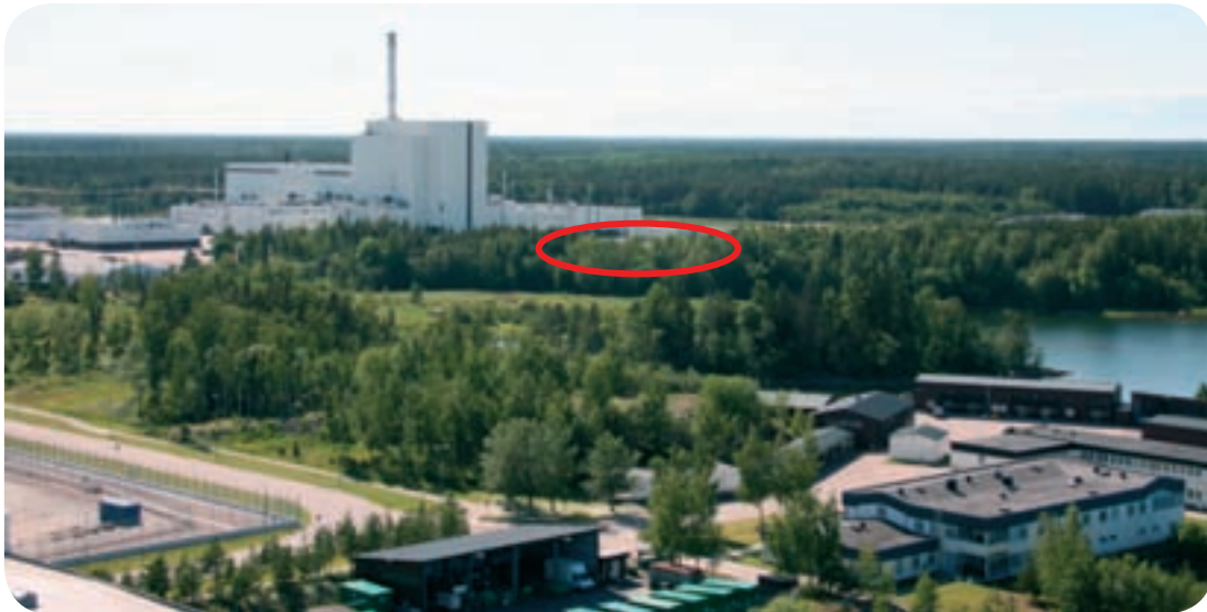
Figur 9-21. Reaktorblock 3 i Forsmark, där den röda markeringen visar det område som övervägts för en lokalisering av inkapslingsanläggningen.
