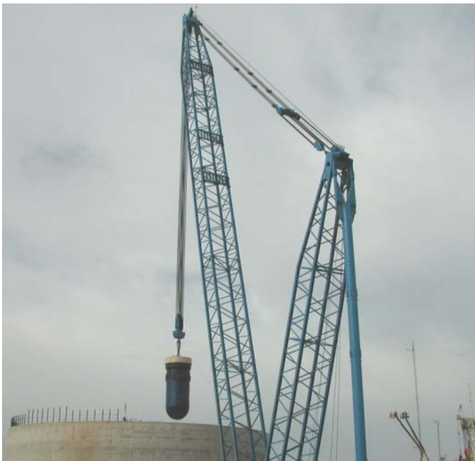
Figur 4-2. Lyft av hel reaktortank (San Onofre).
