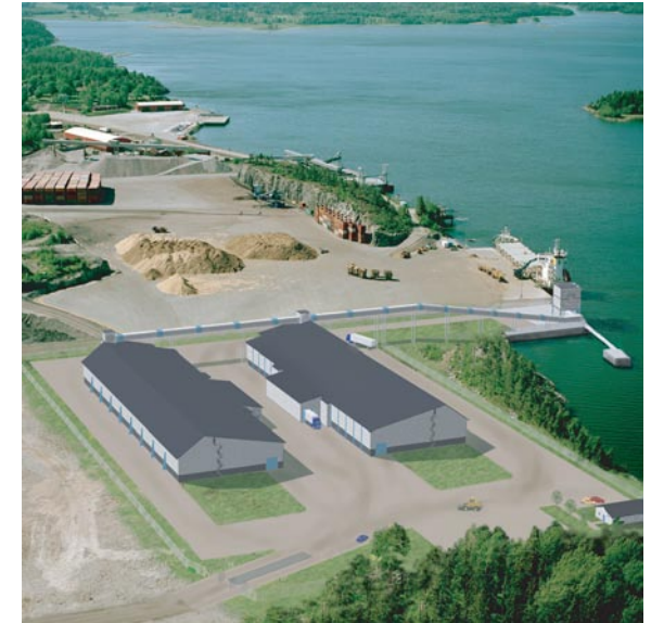
Figur 7-20. Förråd för bentonit.
