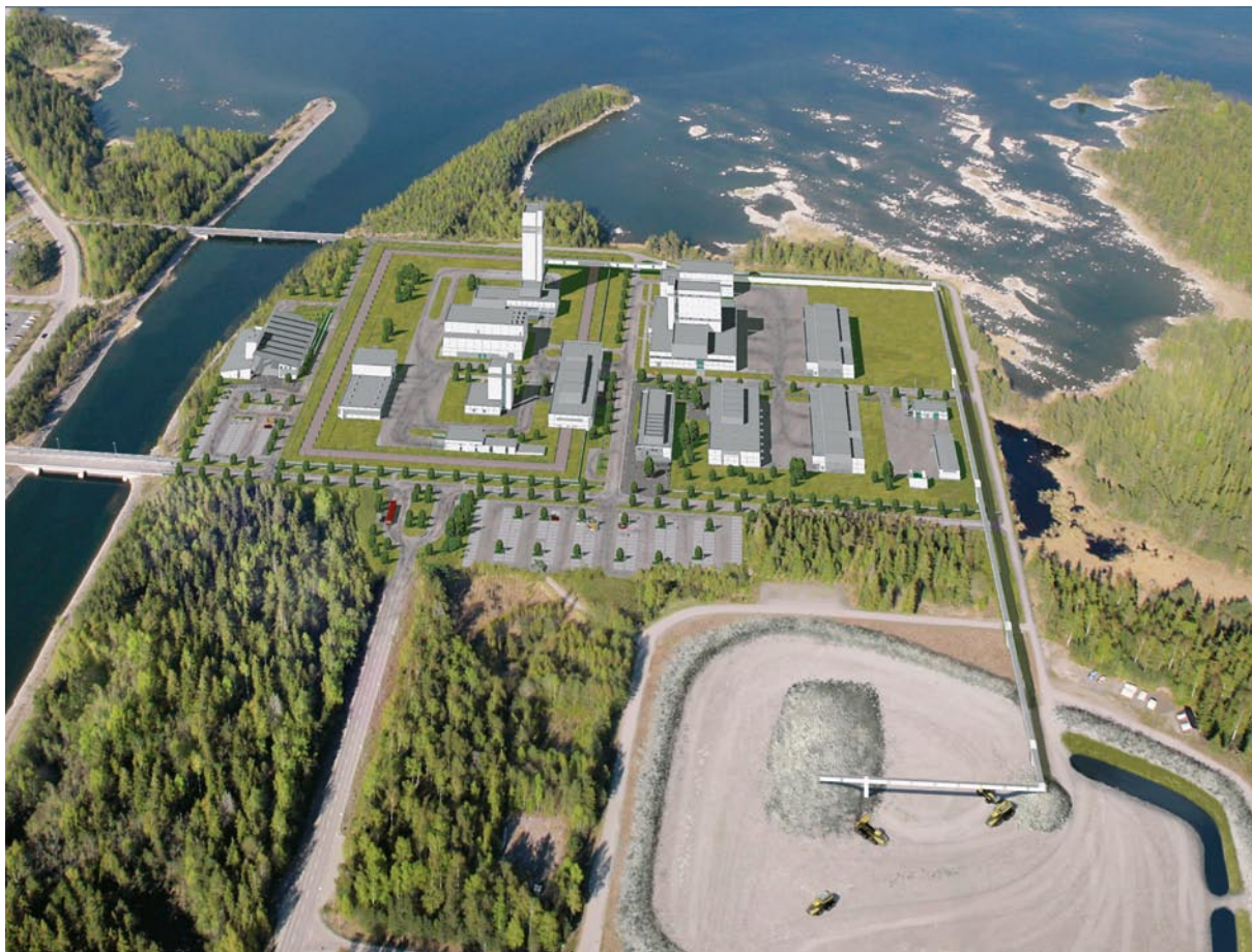
Figur 10-5. Anläggningen vid uppförandets slut.
