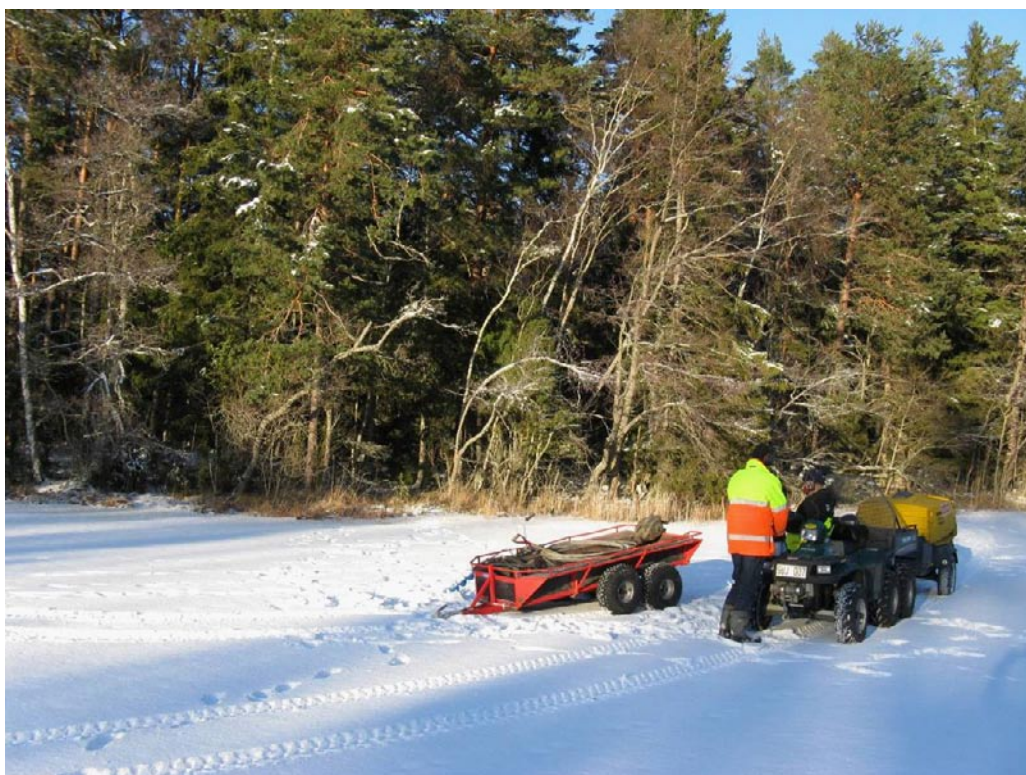
Figur 3-3. En Atlas Copco lufttryckscompressor (på släpet bakom terrängfordonet) användes för rensning av grundvattenrören efter installation. Bilden visar förberedelser inför försondering i våtmarksobjekt 14 (Norra Labbofjärden), belägen väster om sjön Bolundsfjärdens norra del (se figur 5-1).
