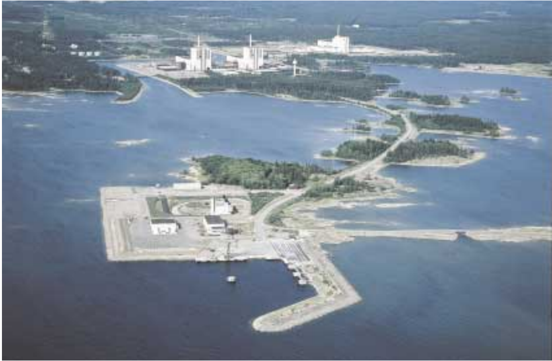
Figur 2-3. Fotografi över Forsmarksverket med de tre reaktorerna samt ovanjordsanläggningen och nedfarten till Slutförvaret för radioaktivt driftavfall, SFR, syns i förgrunden. Foto Göran Hansson/N
