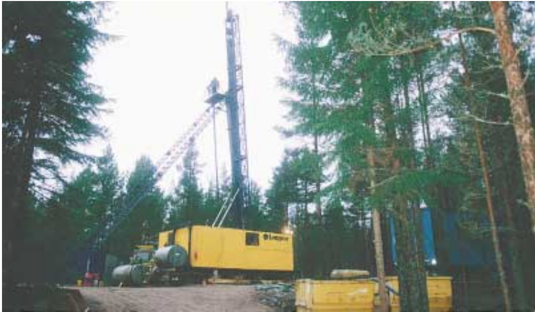
Figur 10. Kärnborrning på en iordningställd borrhålsplats med väganlutning.
