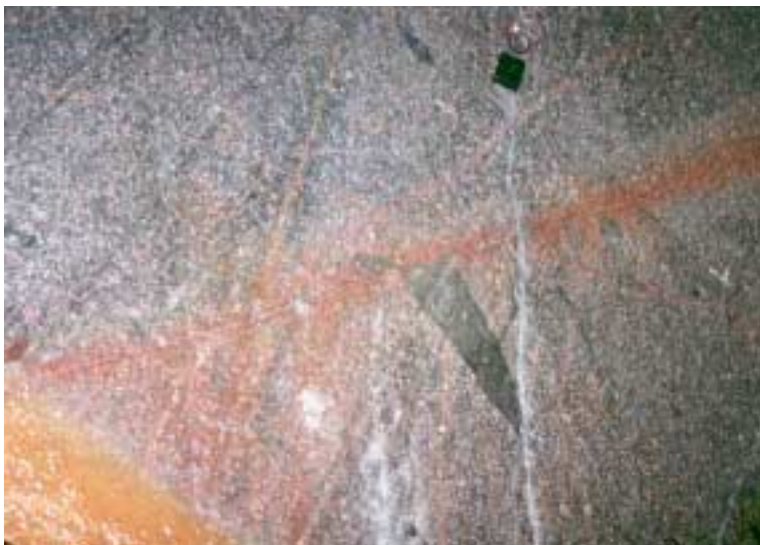
Figur 2-17. Spricka med röd vittring diagonalt över bilden (Äspö HRL).
