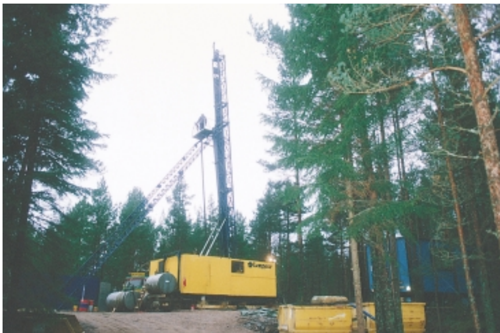
Figur 13-7. Exempel på arbetsplats för kärnborrning.
