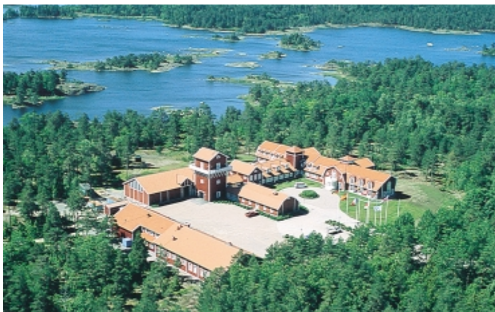
Figur 2-2. Äspölaboratoriet nära Simpevarpshalvön, norr om Oskarshamn.
