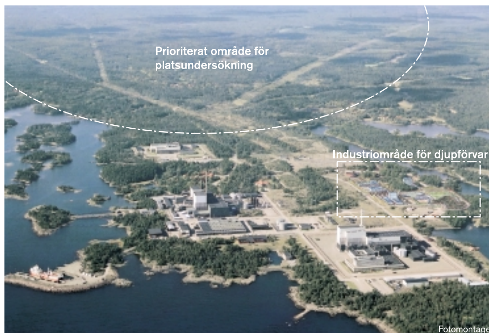
Figur 6. Fotomontage av tänkt placering av djupförvarets ovanjordsdel vid Simpevarp. I bildens bakgrund finns det område som är av intresse för platsundersökningar utöver själva Simpevarpshalvön.
