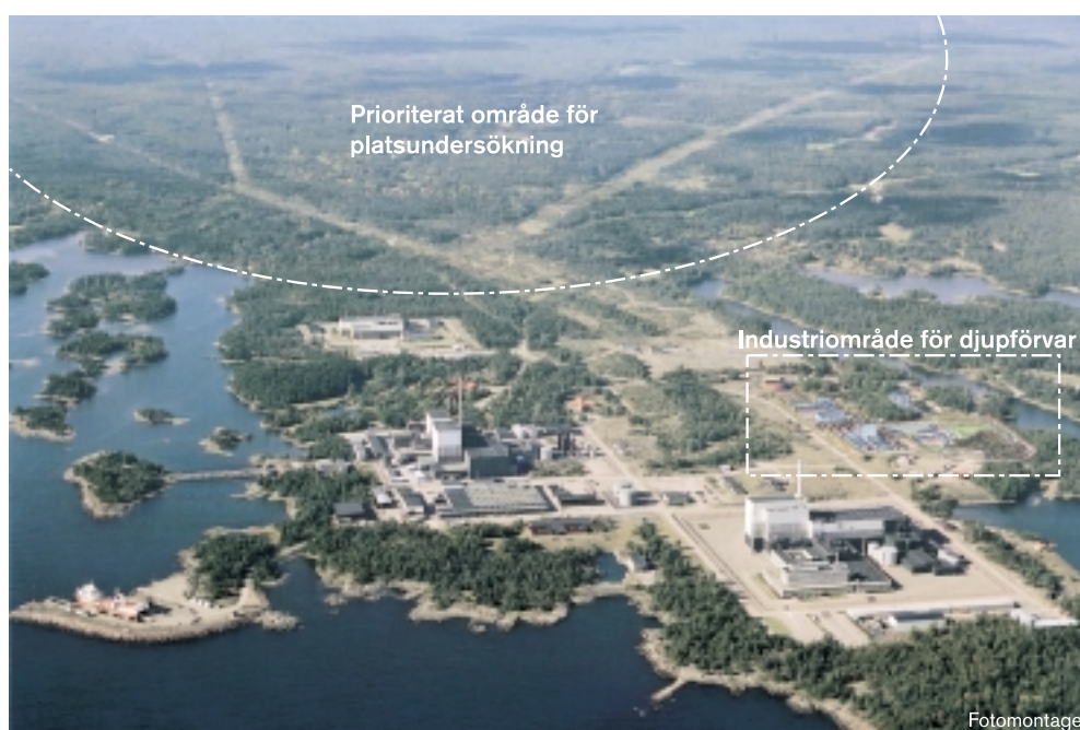
Figur 14-6. Fotomontage av tänkt placering av djupförvarets ovanjordsdel vid Simpevarp. I bildens bakgrund finns det område som är av intresse för platsundersökningar utöver själva Simpevarpshalvön.
