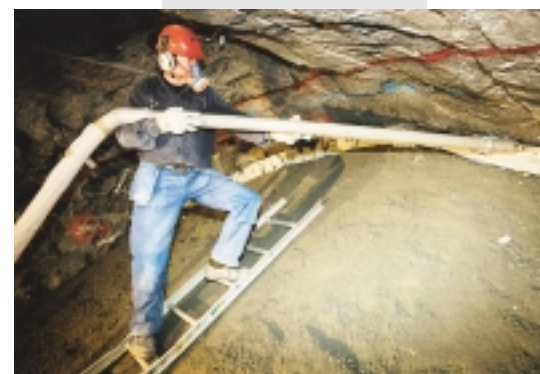
Återfyllning av tunnel i Äspölaboratoriet med en blandning av bentonit och krossat berg
