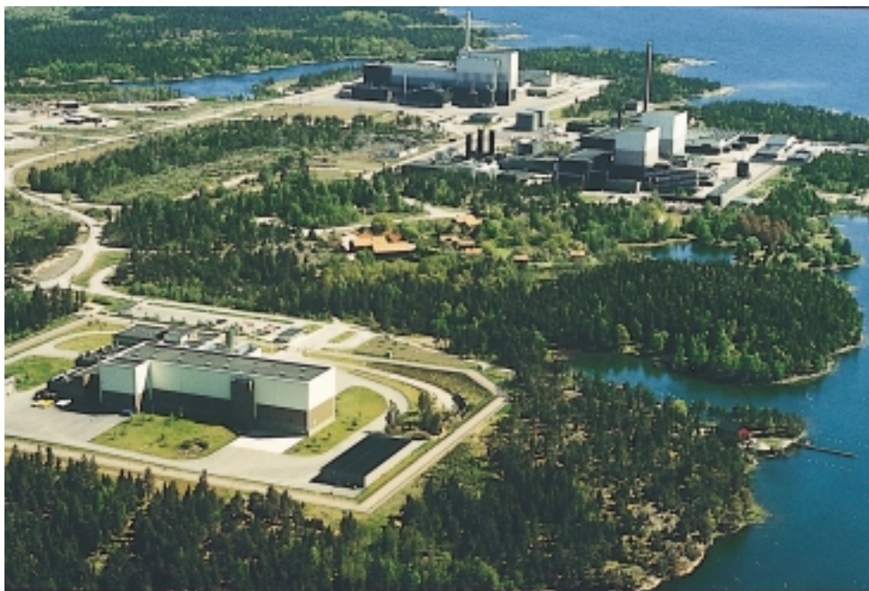
Figur 4-8. Nollalternativet innebär att bränslet lagras i CLAB (ovanjordsdelen i förgrunden) vid Oskarshamns kärnkraftverk under en obestämd framtid.
