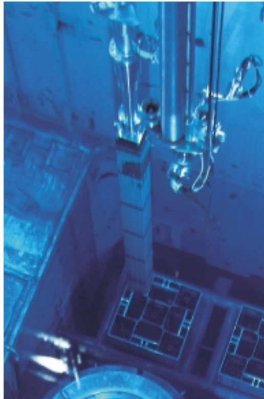
Figur 4-2. I den kemiska miljö som råder i vattenbassängerna i CLAB blir korrosionen på bränslet mycket långsam.
