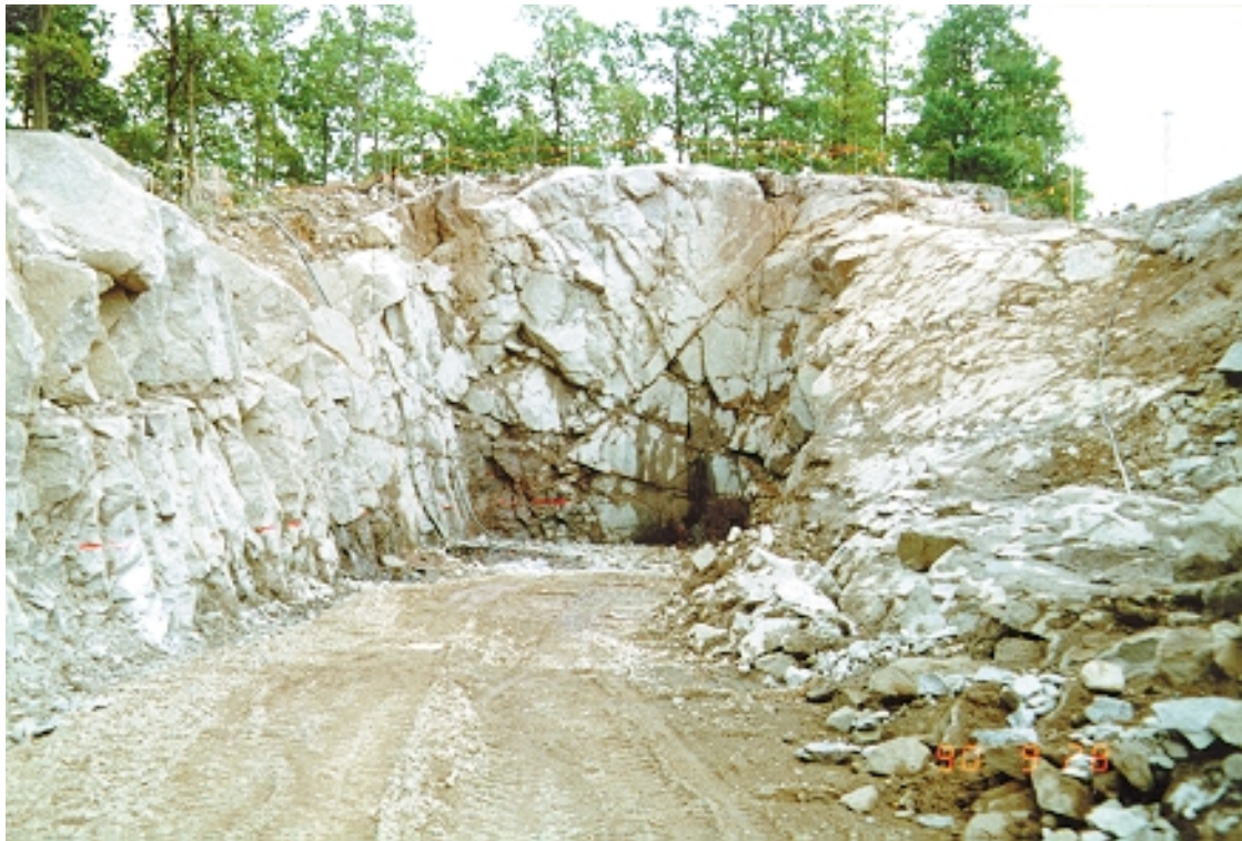
Figur 4-3. Tunnelpåslag till Äspölaboratoriet.
