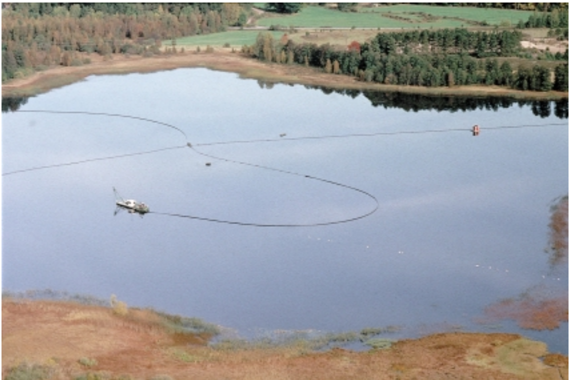
Figur 3-7. Pågående saneringsarbete i Järnsjön. Foto: Hultsfreds kommun.
