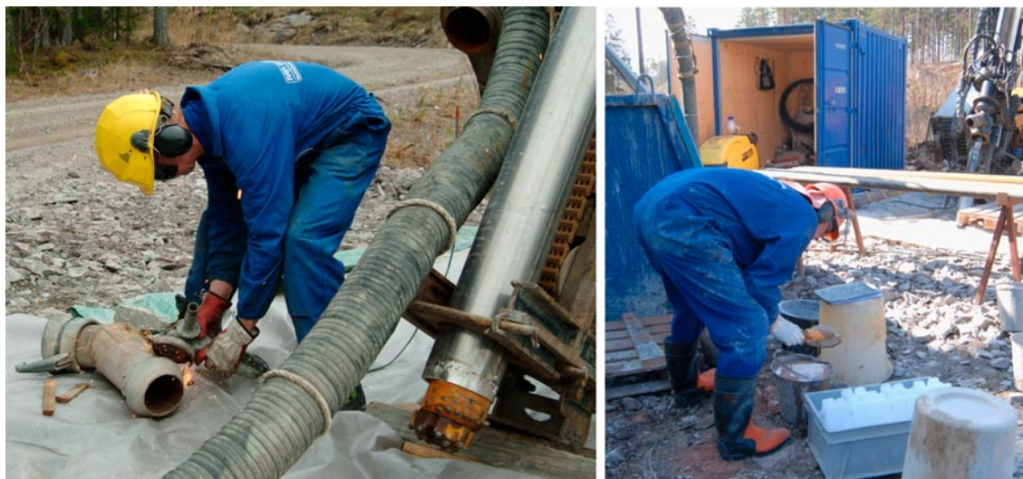
Figur 4-2. Hammarborrning. I bilden till vänster har det rostfria foderröret ansatts för borras genom jordlagret. Under borrmaskinen finns en presenning och en fibermatta för att undvika jordlagerkontamination av olja mm som eventuellt kan läcka från borrmaskinen. Vid borring leds borrkax och vatten från avledarhuvudet till cyklonen där borrkax samlas upp, provtas och karteras översiktligt (bilden till höger). Borrsjunkning och flöde mäts manuellt och skrivs in i protokoll.
