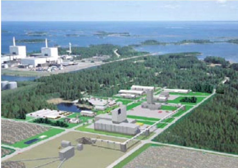
Figur 2-2. Ovanjordaneläggning vid Forsmark.
