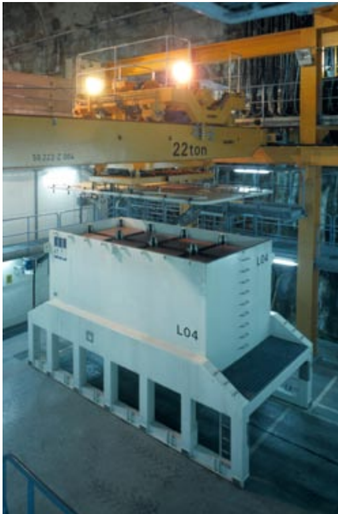
Figur 1-4. Locket på en ATB transportbehållare för radioaktivt avfall lyfts av.
