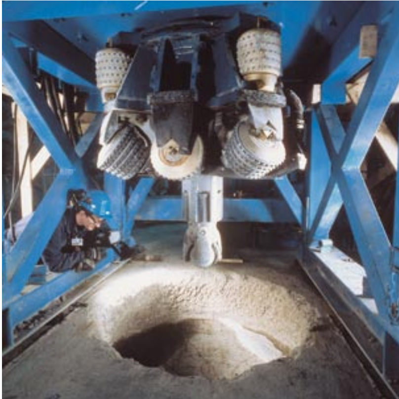
Figur 12-5. Borrning av deponeringshål med omvänd stigortsborrning i Olkiluoto genomförd i ett samarbetsprojekt mellan SKB och Posiva.
