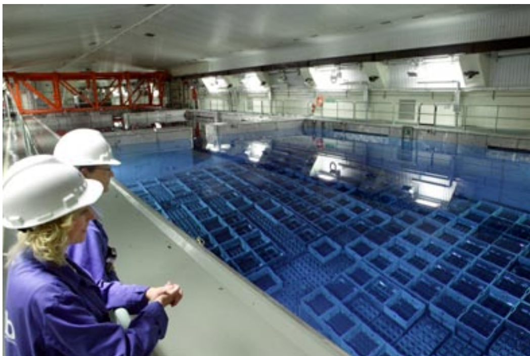
Figur 1-3. Det centrala mellanlagret för använt kärnbränsle.
