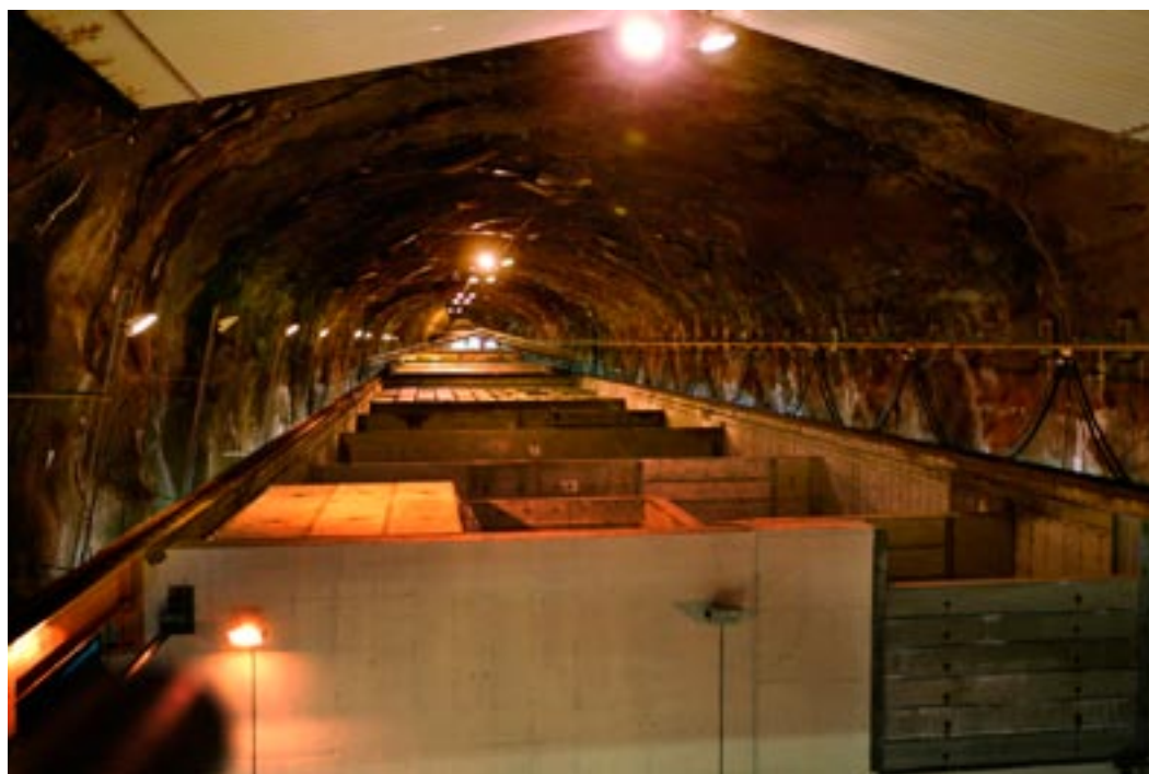
Figur 1-2. Interiör från slutförvaret för låg- och medelaktivt driftavfall.
