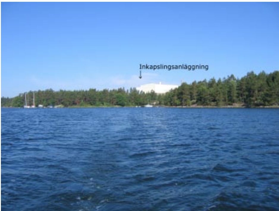
Bilden visar Clab och Inkapslingsanläggningen från platsen I.
