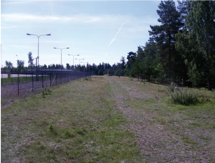
Figur 4-3. Befintligt industriområde vid Clab kommer att flyttas ut 50 m över den här ytan vid byggnation av inkapslingsanläggningen.
