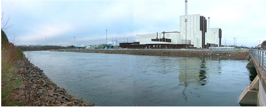
Figur 2-2. Byggnader för Forsmarks reaktor 1 och 2 med en tillskapad vattenkanal i förgrunden.
