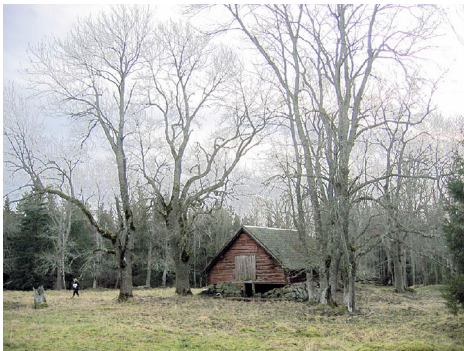
Figur 4-1. Byggnad som hört till torpet Rönngrund, objekt 16/RAÄ 83.
