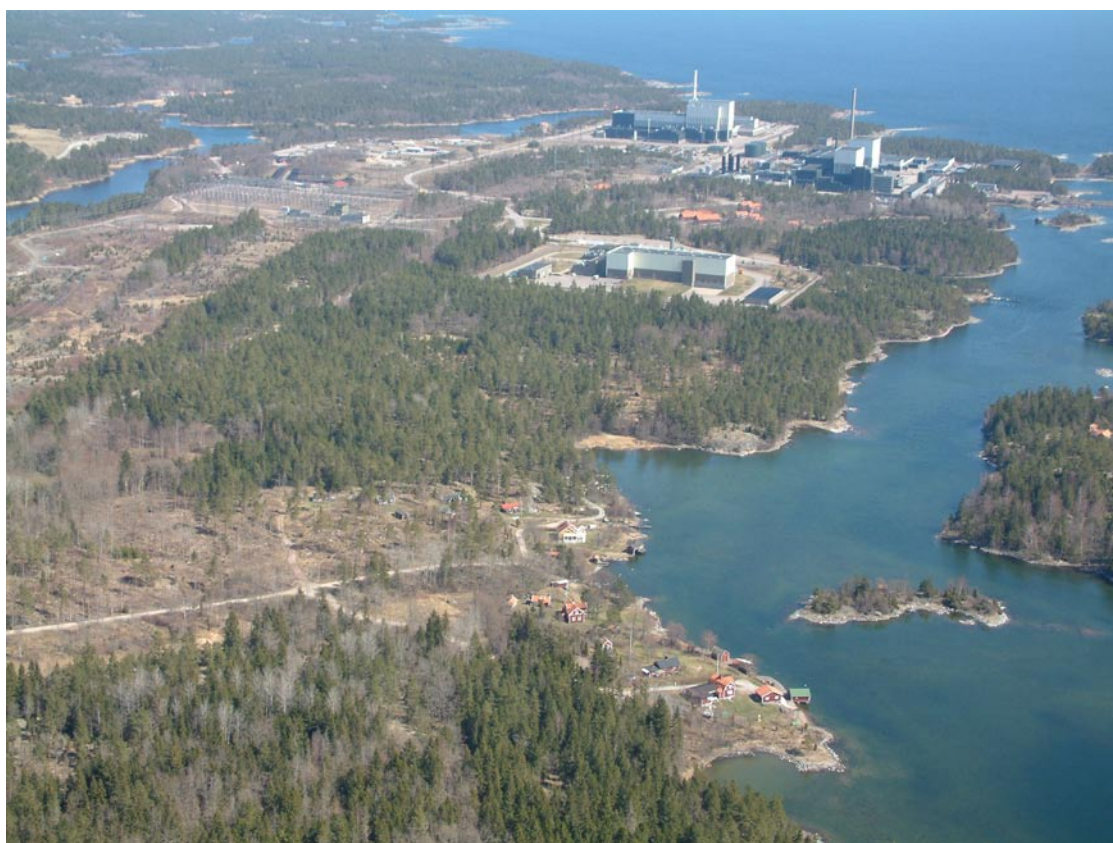
Figur 2-9. Industriområdet i Simpevarp med de tre kärnkraftblocken, Clab och Simpevarps hamn.
