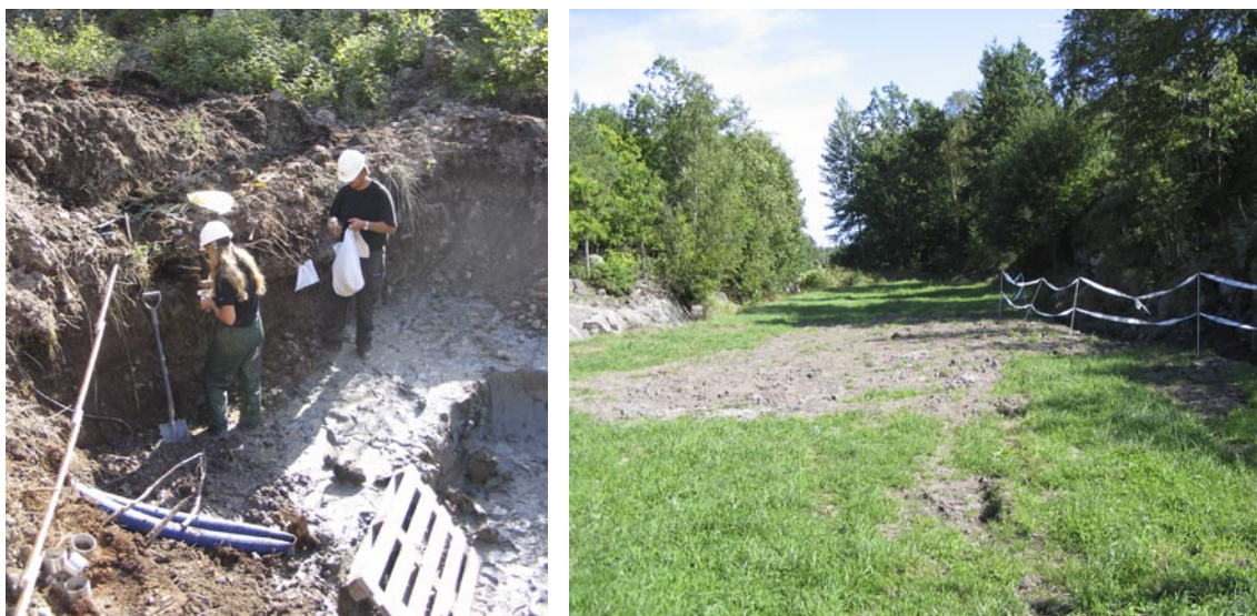
Figur B-2. Grävdikey för jordartskartering före och efter återställning.
