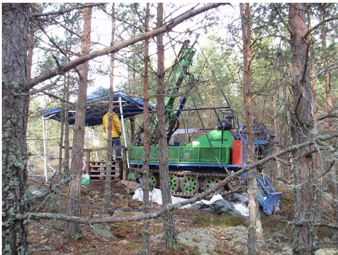
Figur B-4. Lätt bormaskin för börning av korta borrhål.
