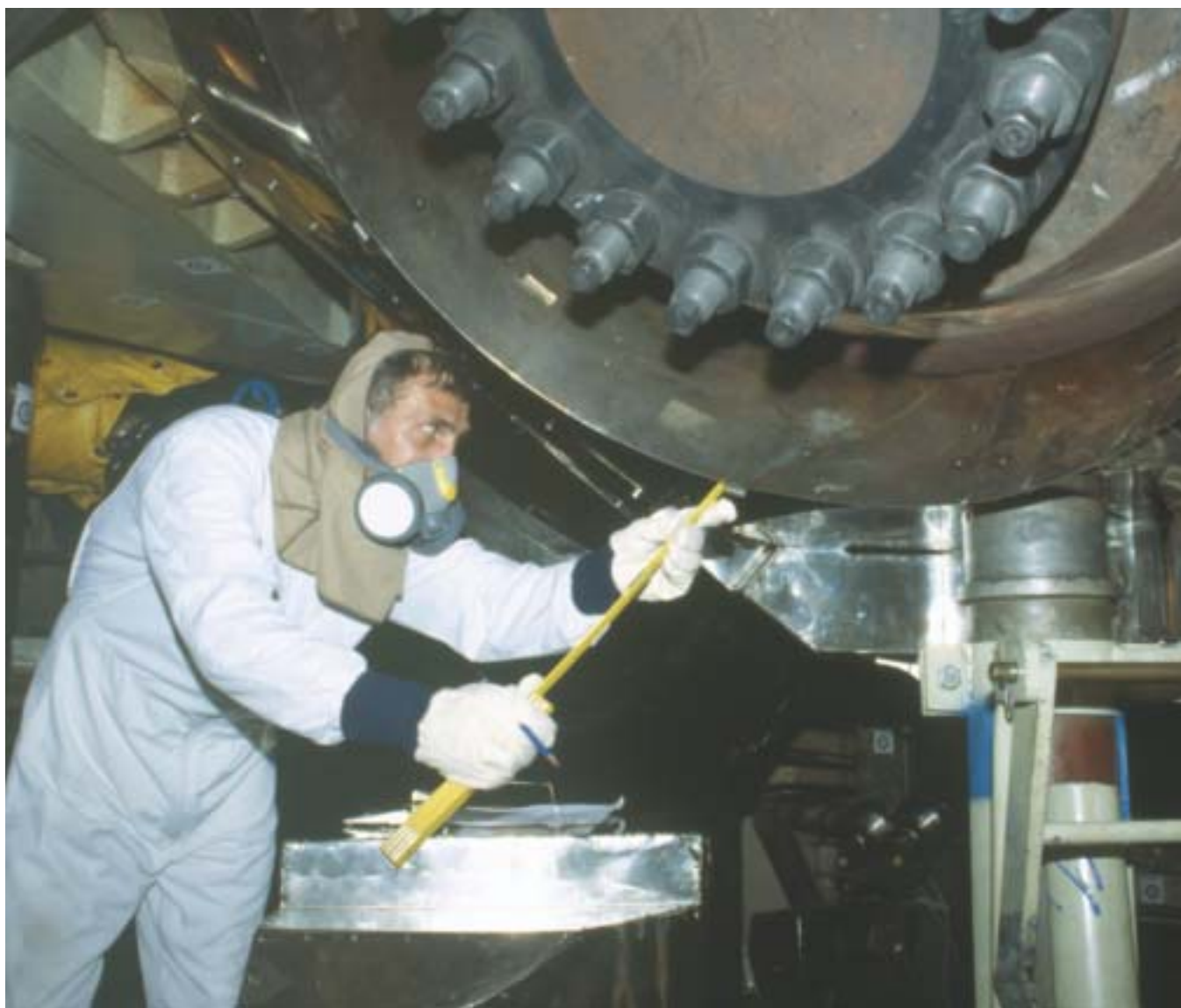
Alla ytor som på något sätt har varit i kontakt med vattnet i reaktorn är mer eller mindre nedsmutsade av radioaktiva ämnen.
